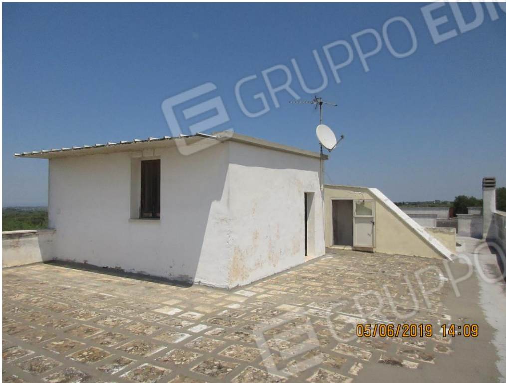
Foto n.34 Locale ad uso deposito al livello lastrico solare
