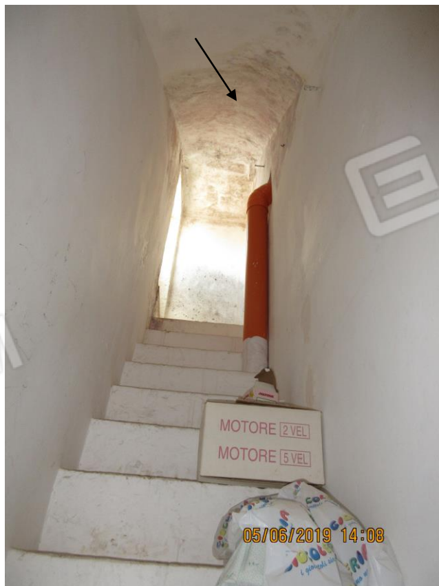
Foto n.32 e 33 Tracce dei fenomeni di infiltrazioni
