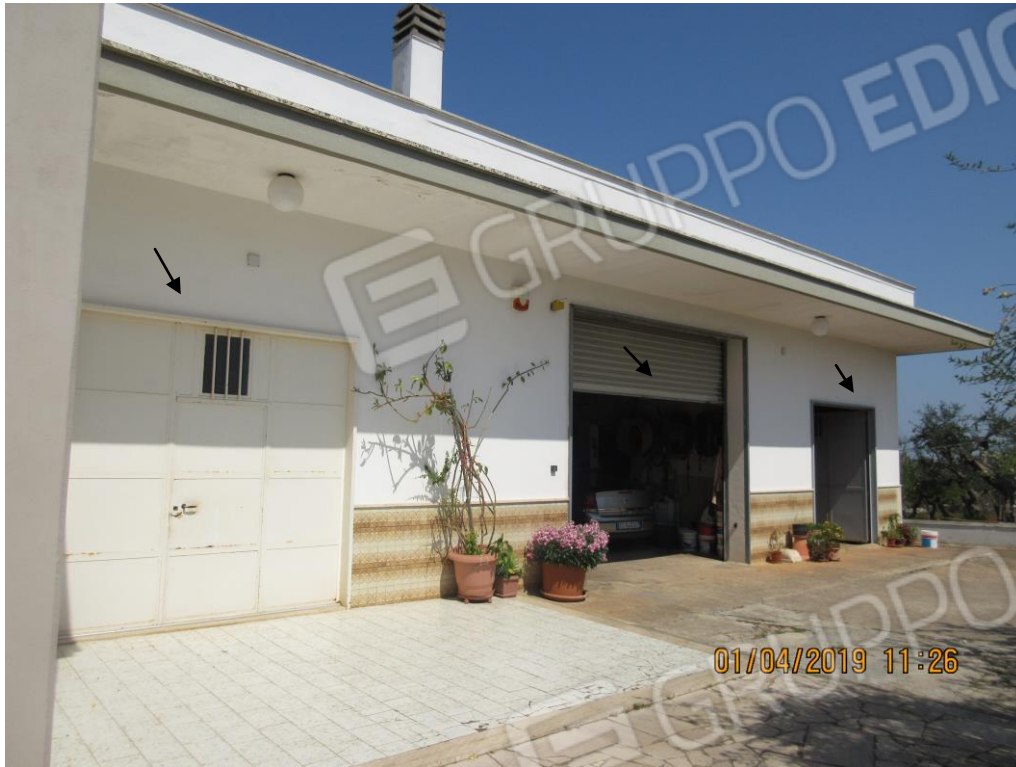
Foto n. 6 Ingresso nei n. 3 locali / deposito
