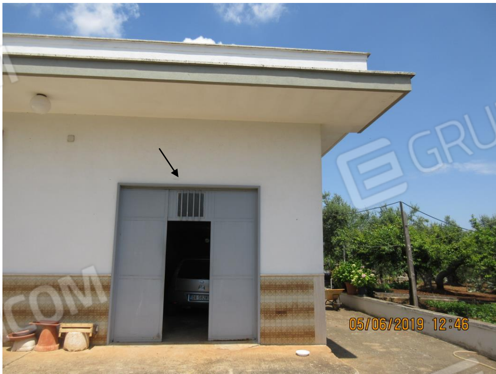
Foto n.39 Locale deposito / Ambiente n.12
