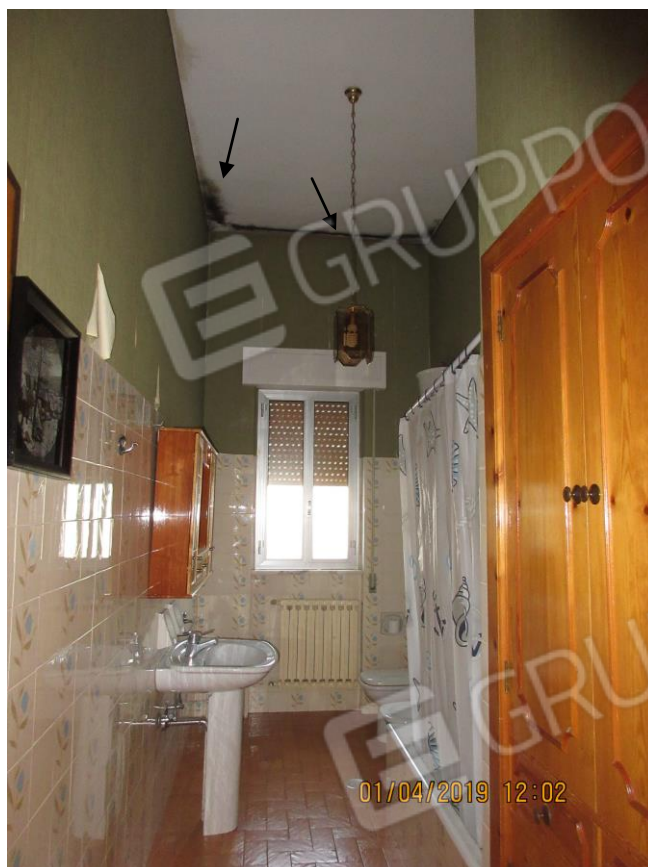
Foto n. 24 e n.25 Fenomeni di condensa sul soffitto del bagno
