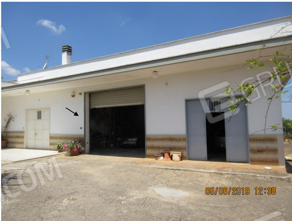
Foto n.37 / Deposito ambiente n.11
