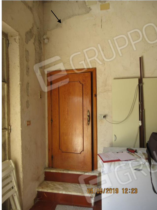
Foto n.32 e 33 Tracce dei fenomeni di infiltrazioni
