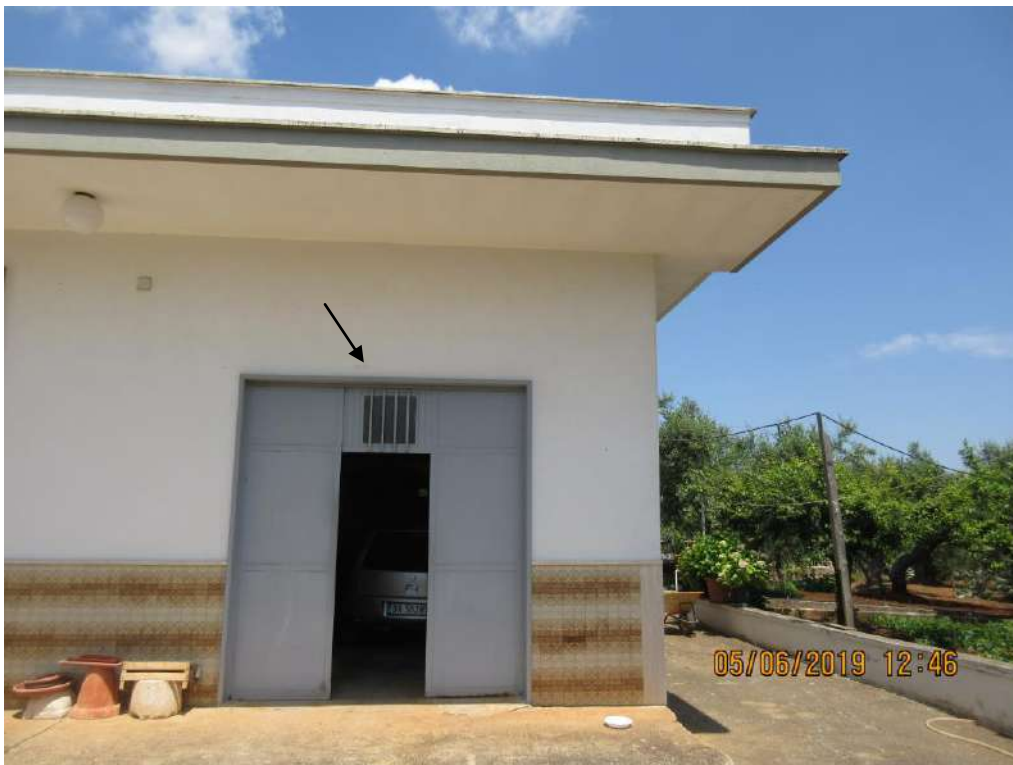
Foto n.39 Locale deposito / Ambiente n.12
