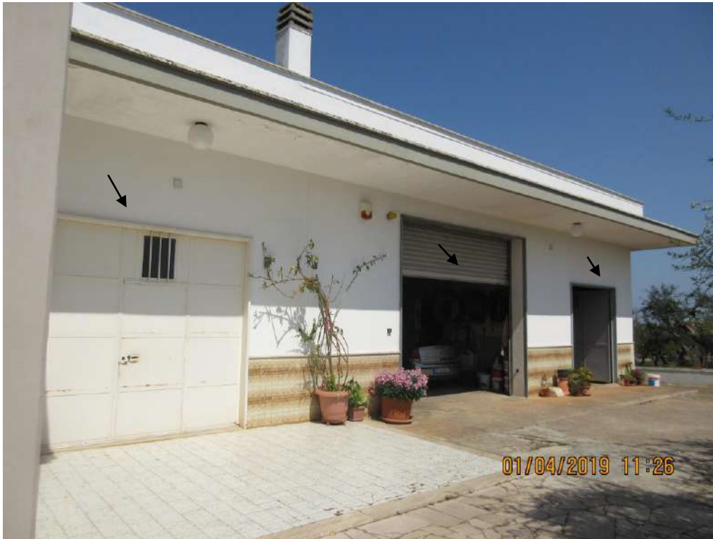
Foto n. 6 Ingresso nei n. 3 locali / deposito
