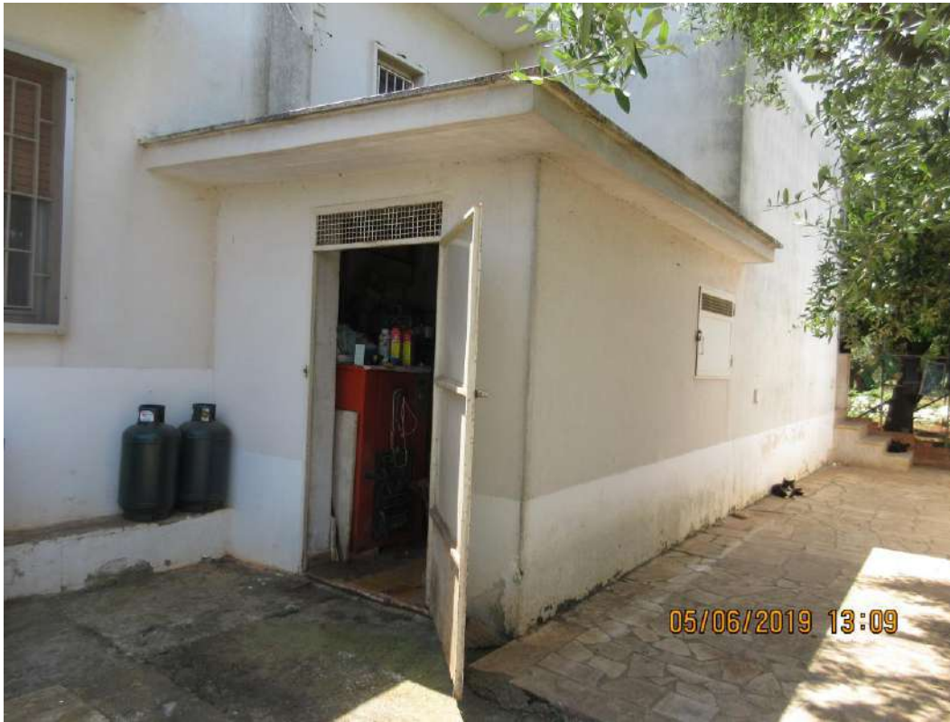
Foto n.44 Locale centrale termica adiacente e sul retro del fabbricato
