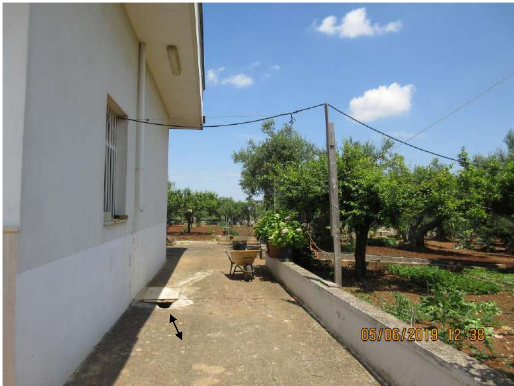
Foto n.41 Ingresso nella Cisterna / Vasca di raccolta acque meteoriche
