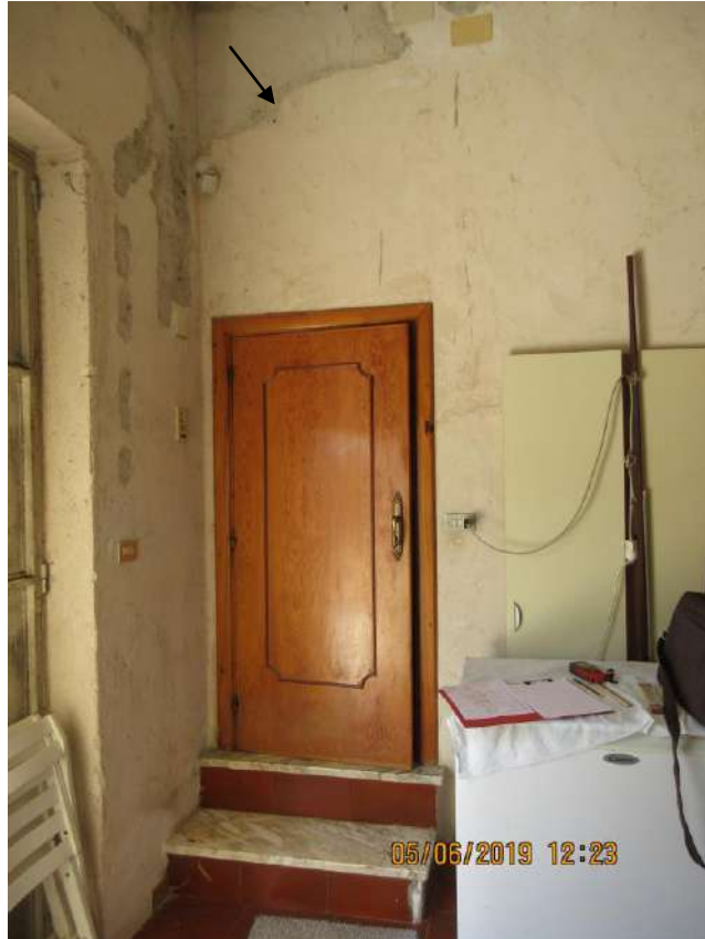
Foto n.32 e 33 Tracce dei fenomeni di infiltrazioni
