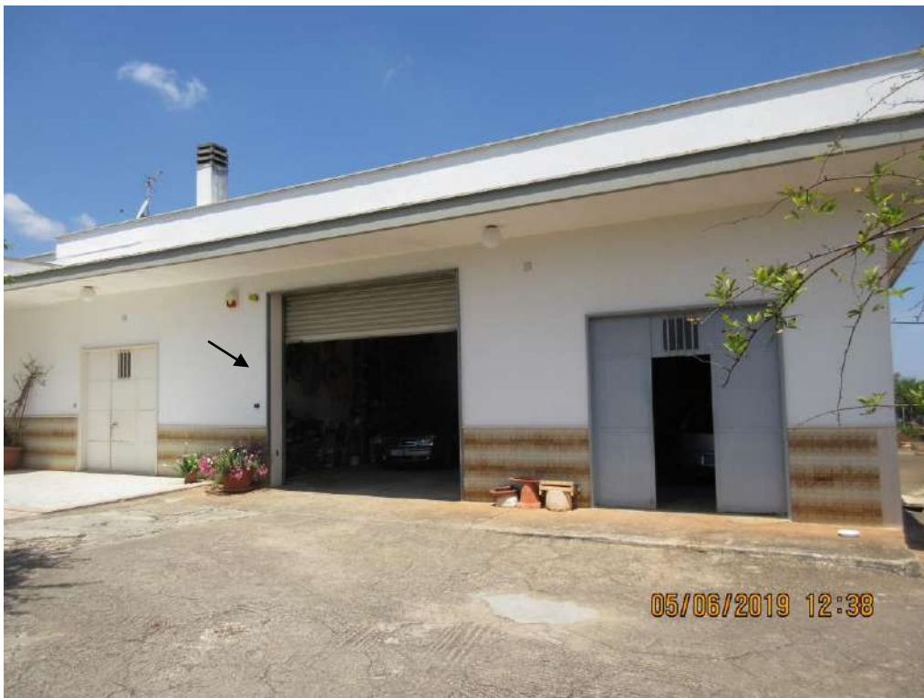
Foto n.37 / Deposito ambiente n.11
