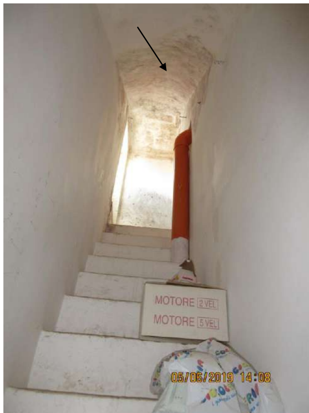
Foto n.32 e 33 Tracce dei fenomeni di infiltrazioni
