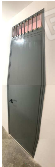
Foto nn. 34-35-36-37. Piano S1. Cantina 1
