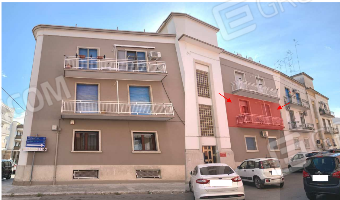
Foto nn. 1-2. Appartamento per civile abitazione al piano primo interno 4 con annesse due cantine al piano S1 interno 4, sito in Acquaviva delle Fonti (BA) alla Via Don Cesare Franco n. 71. Palazzina condominiale
