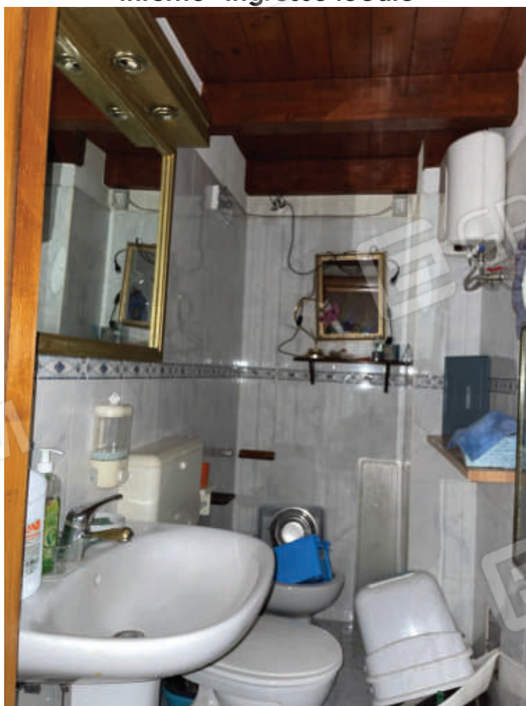
Interno- Particolare WC esistente
