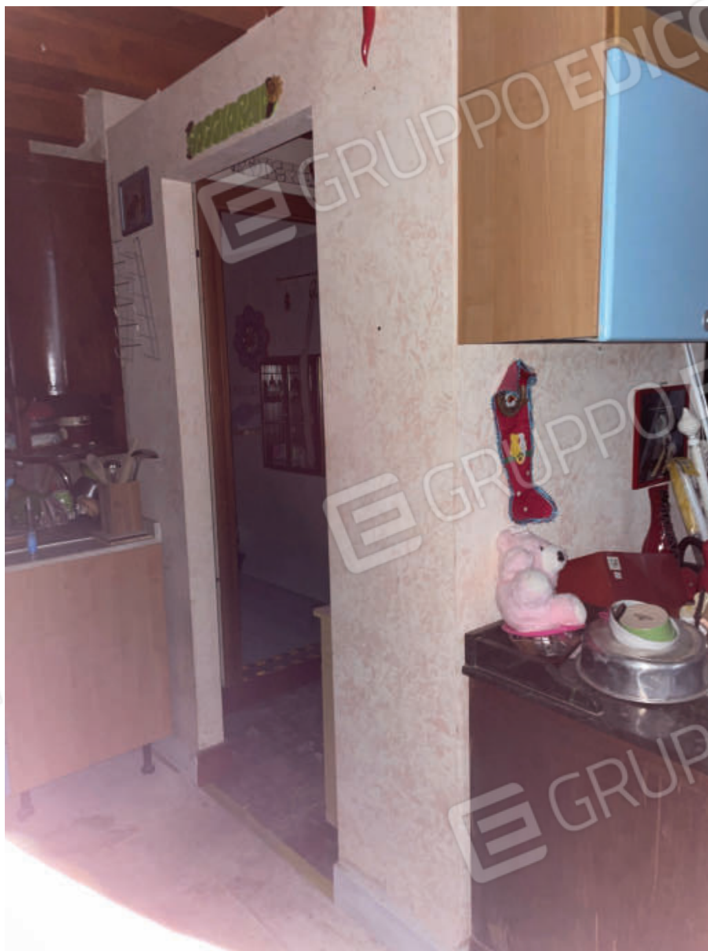
Interno- Particolare antibagno esistente
