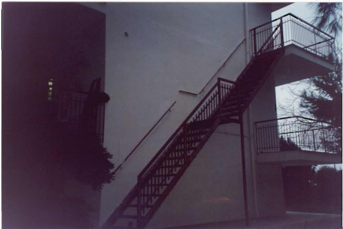
Figura 32: . Palazzina alla Via San. Girolamo 24 – 24/a - scala di sicurezza esterna.
