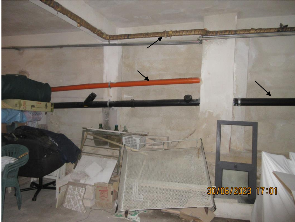
Foto n.11 Tubazioni attive del Condominio ( nero ed arancio) , in alto invece tubazioni dell'impianto di riscaldamento centralizzato dismesso
