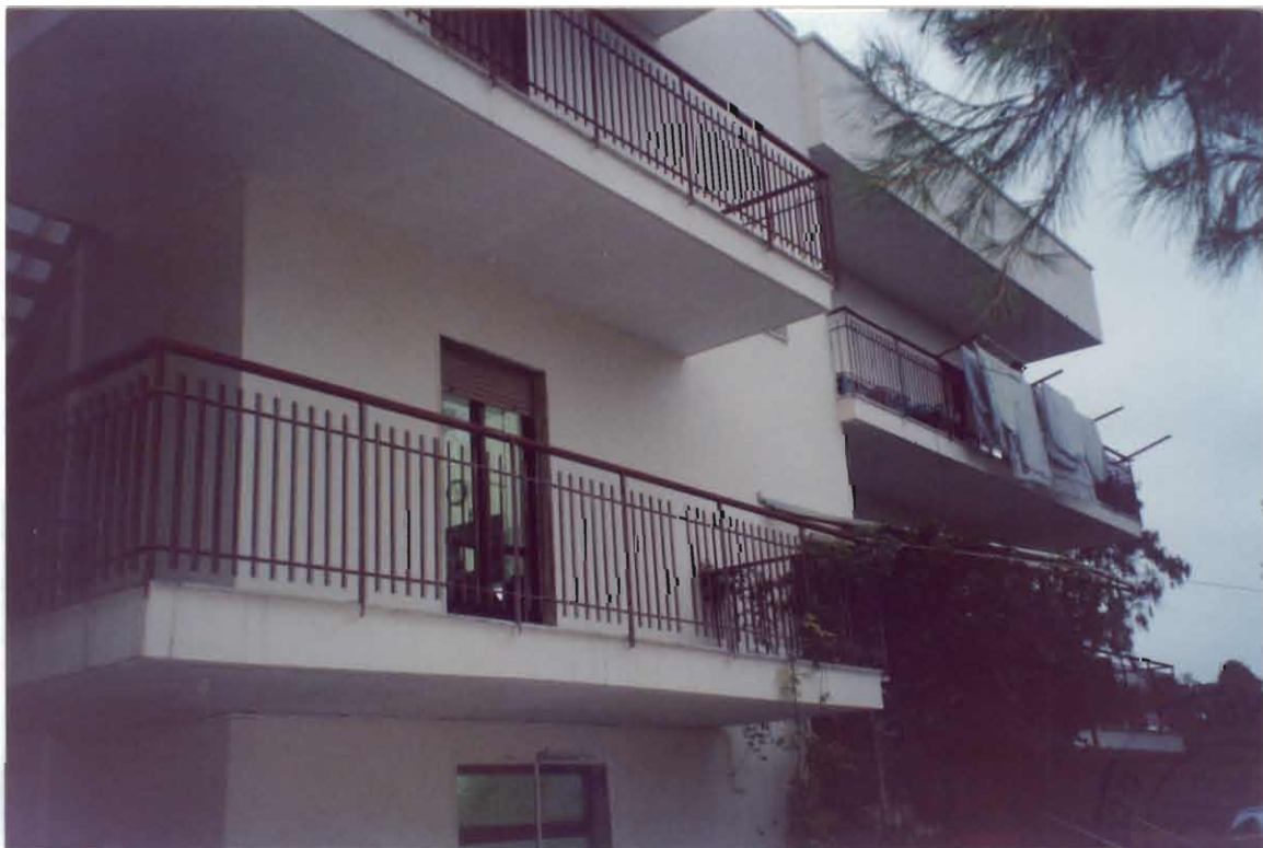
Figura 30: . Palazzina alla Via San. Girolamo 24 – 24/a - Facciata esterna
