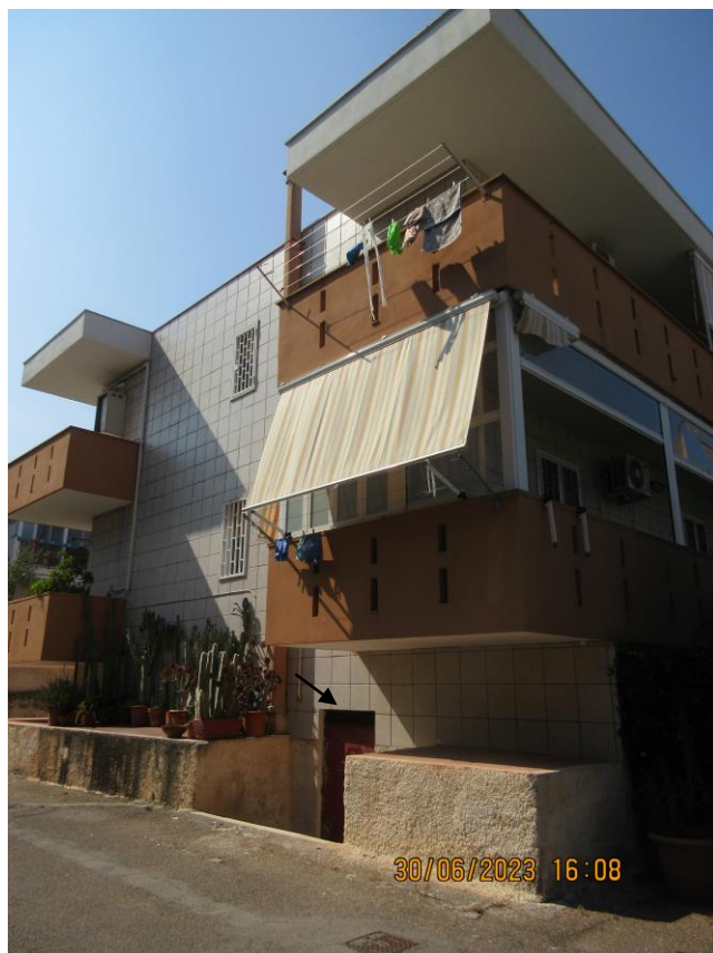
Foto n.5 Prospetto parallelo ed opposto alla Strada S Girolamo con l'indicazione della porta color rosso di accesso nel locale seminterrato
