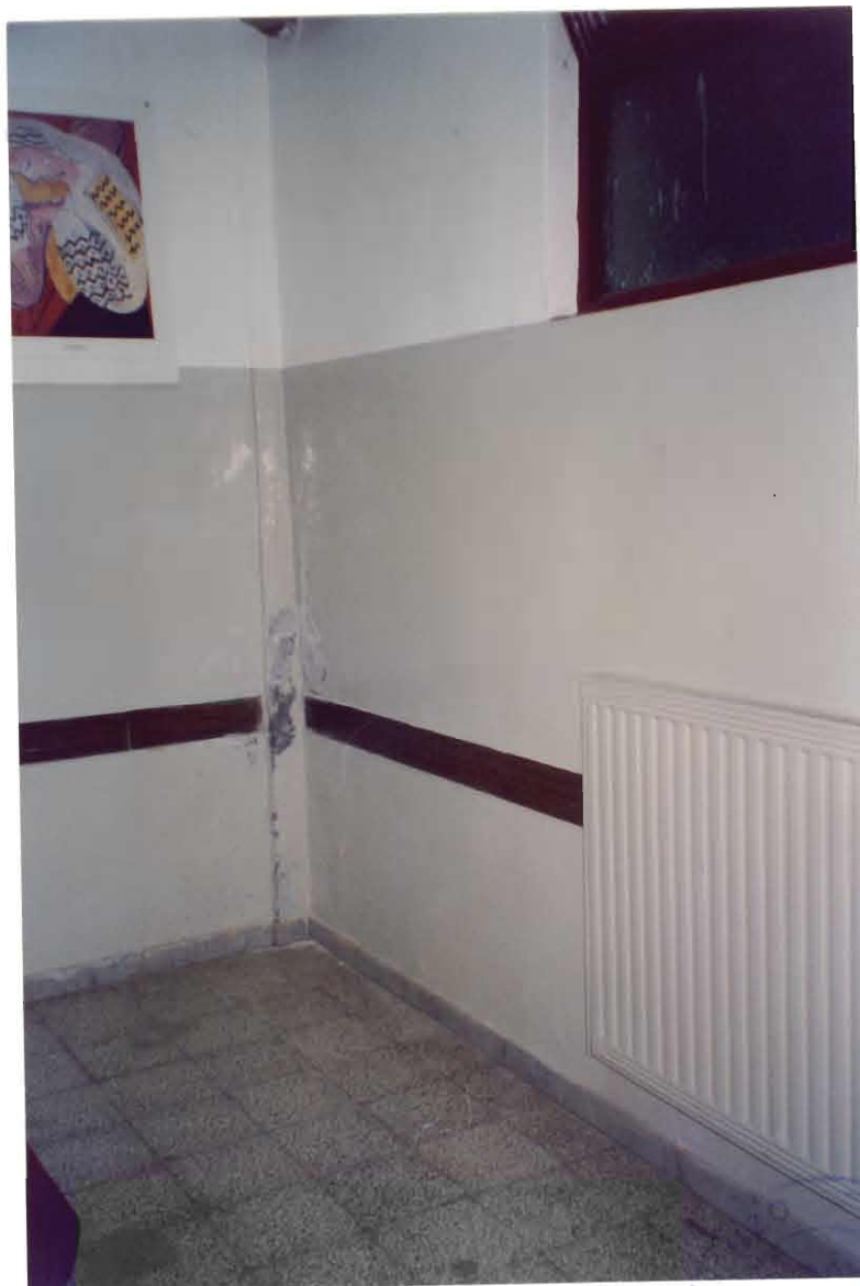
Figura 33: Palazzina alla Via San Girolamo 24 – 24/a, piano seminterrato, si nota il pavimento in marmette di cemento.
