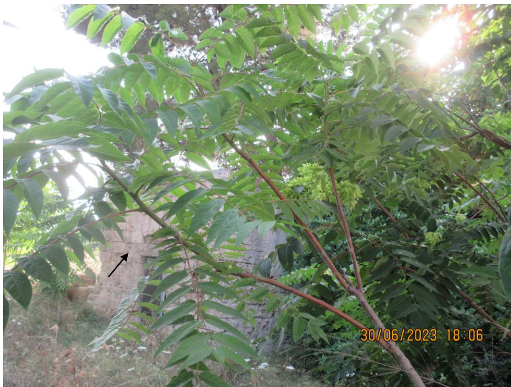
Foto n.27 Vista del fabbricato diruto all'interno del Lotto
