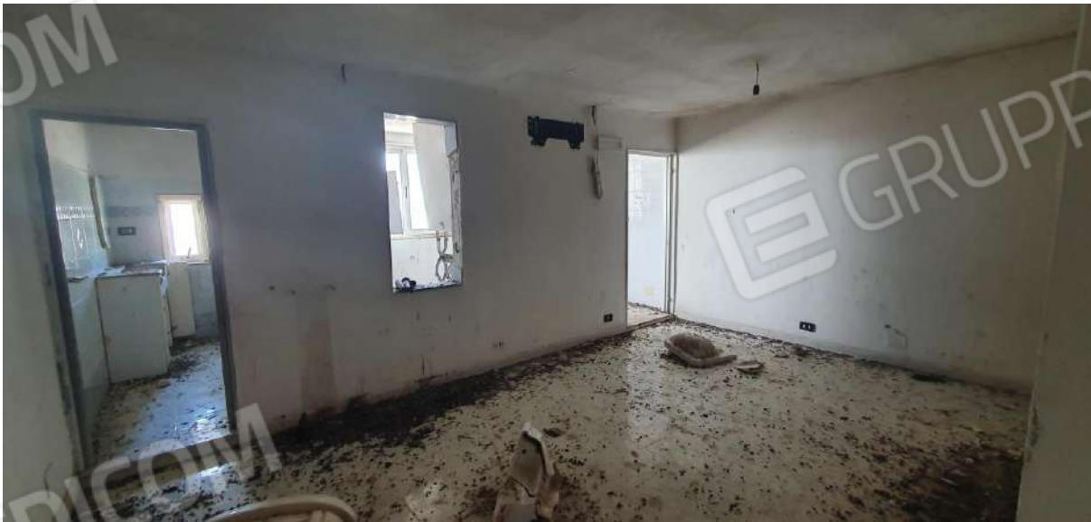
Foto n.15 Vista del bagno (a sx) e della cucina ( a dx)
