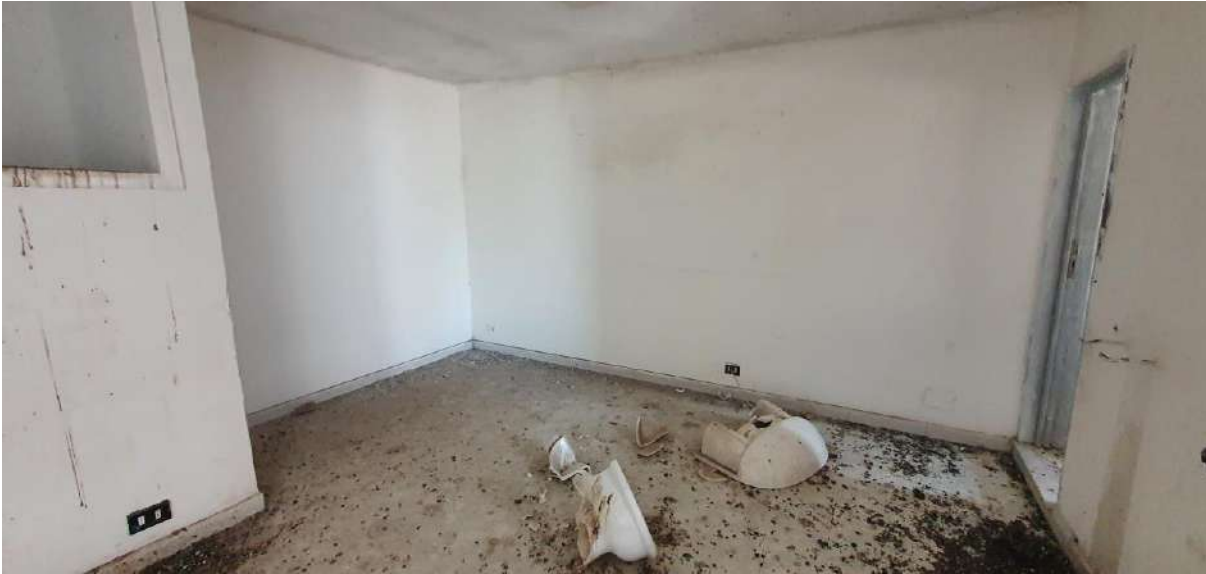
Foto n.16 Vano principale al 2 a piano
