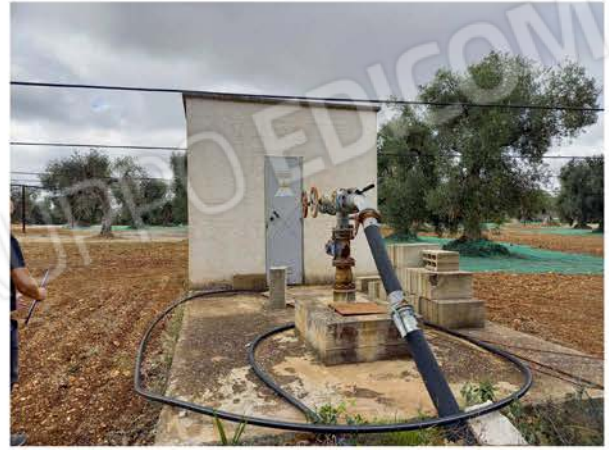
Vista all'interno dell'uliveto (Pozzo artesiano)
