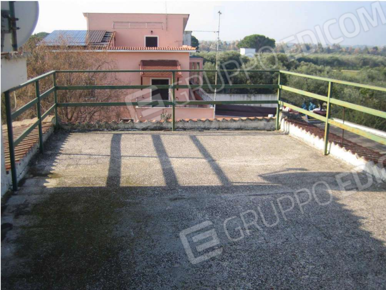
Foto n° 46 – lastrico solare A30 dell'Immobile pignorato
