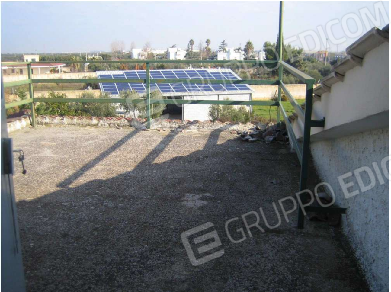
Foto n° 43 – lastrico solare A29 dell'Immobile pignorato
