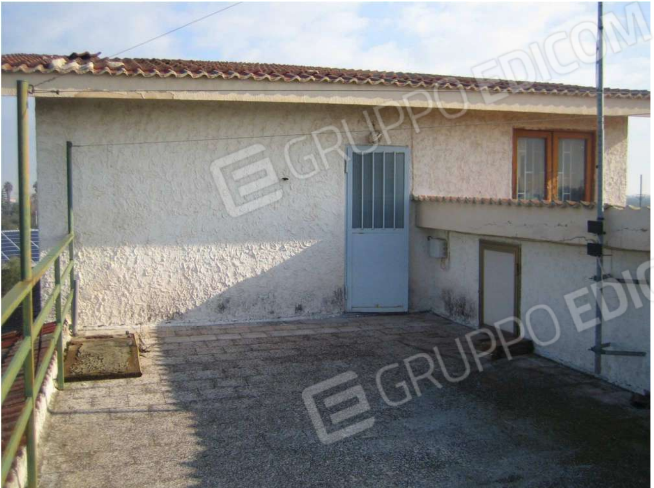
Foto n° 47 – lastrico solare A30 dell'Immobile pignorato
