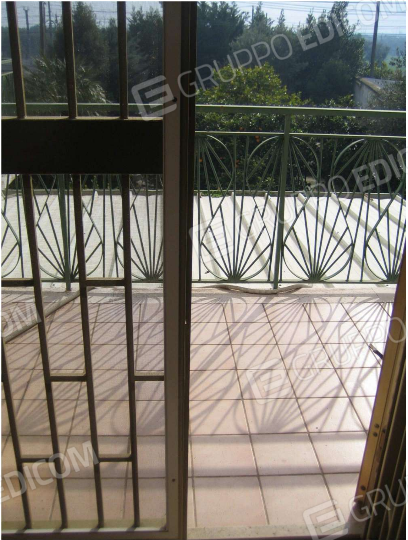
Foto n° 42 – balcone A28 al piano primo dell'Immobile pignorato
