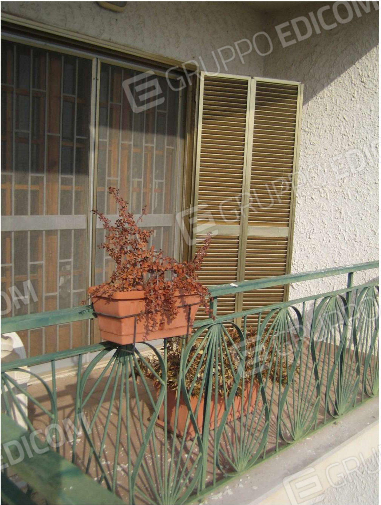
Foto n° 22 – balcone A13 al piano primo dell'Immobile pignorato
