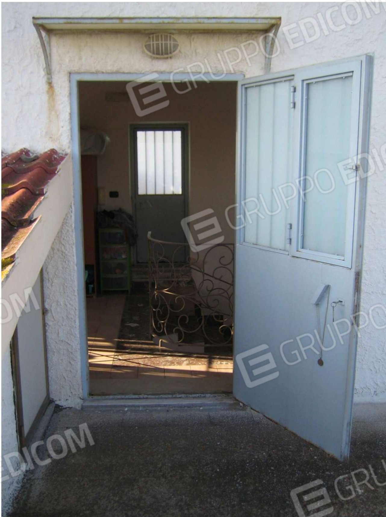
Foto n° 44 – porta lastrico solare A29 dell’Immobile pignorato
