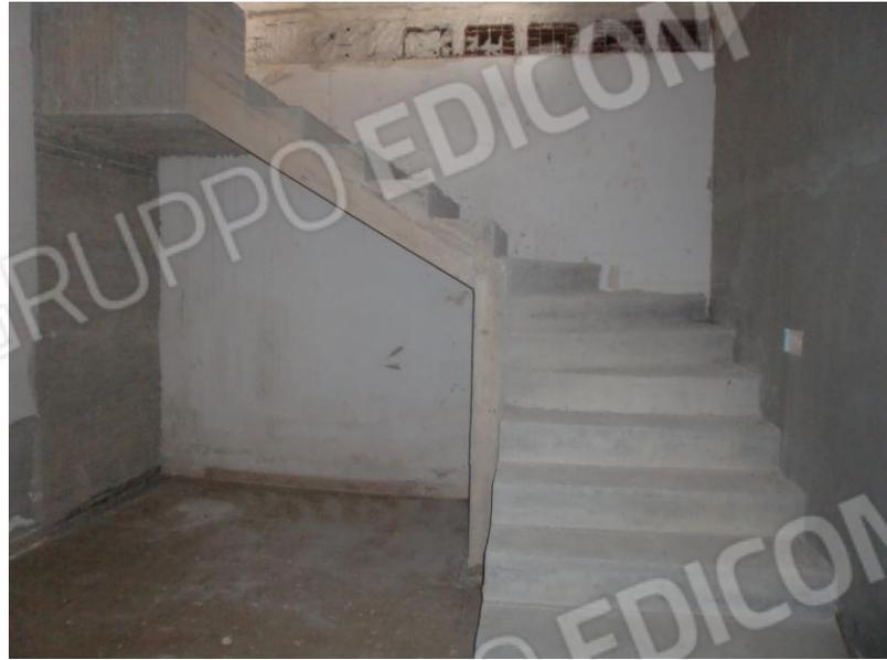
Foto . 09: Sbarco al piano seminterrato della scala in c.a.
