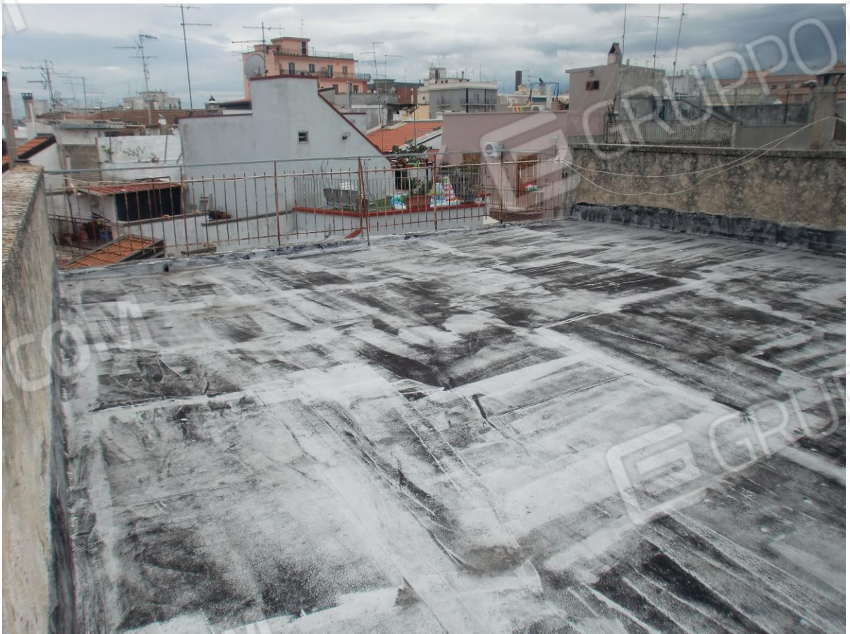
Foto n. 40: Lastrico solare di copertura al terzo piano prospiciente Via Le Strettele
