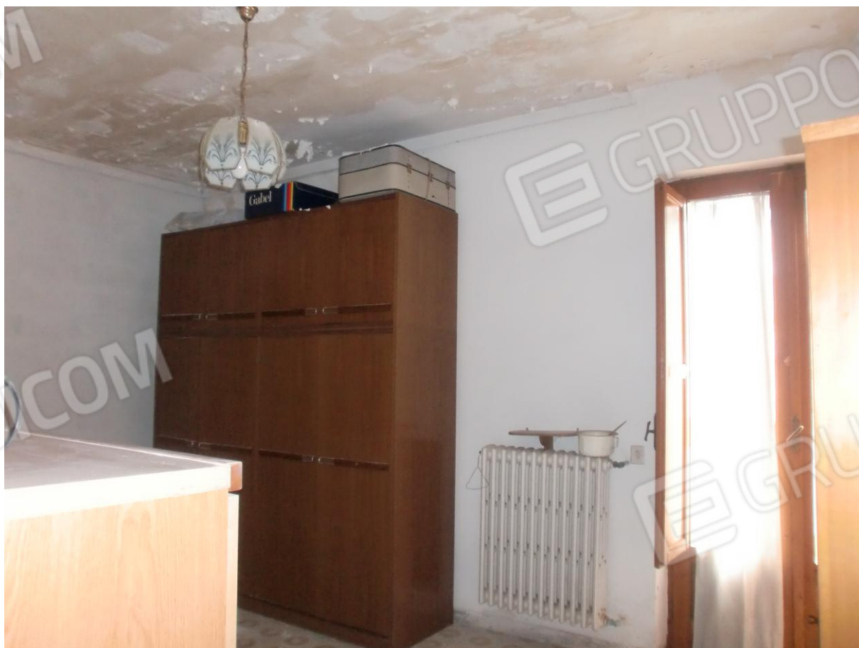
Foto n. 32: Vano 2 del secondo piano prospiciente terrazzino su Via Le Strettole
