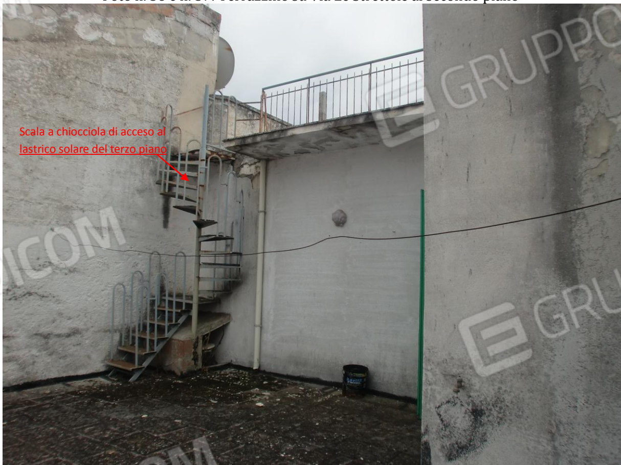
Foto n. 38: Terrazzo a livello al secondo piano, prospiciente Via V. Oliva
