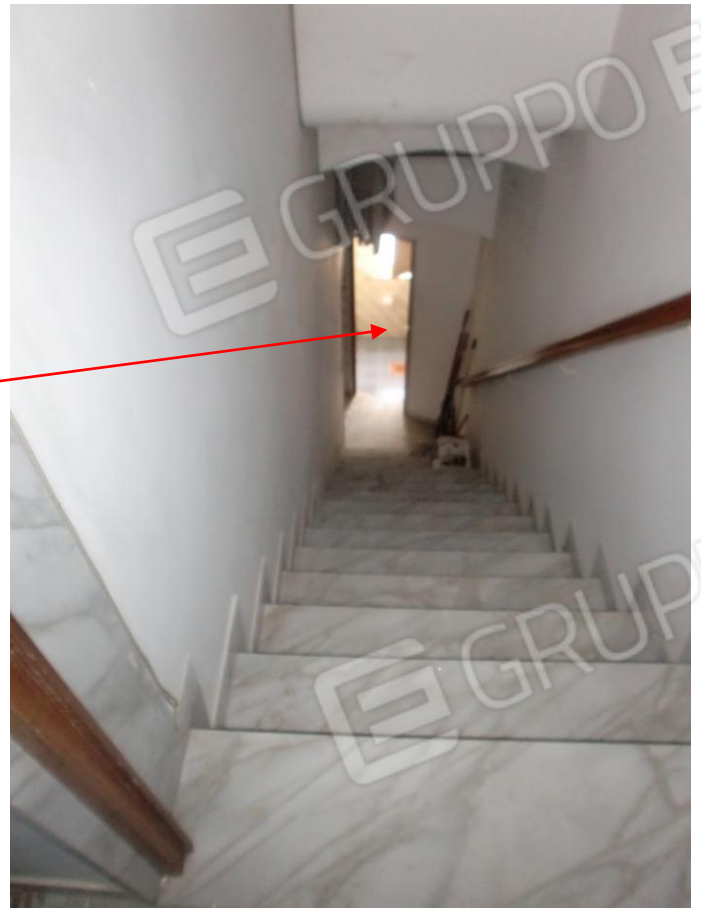
Foto n. 30: Scala tra il I ed il II piano
