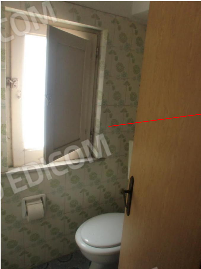
Foto n. 29: Bagno ad angolo nel vano scala di collegamento al II piano
