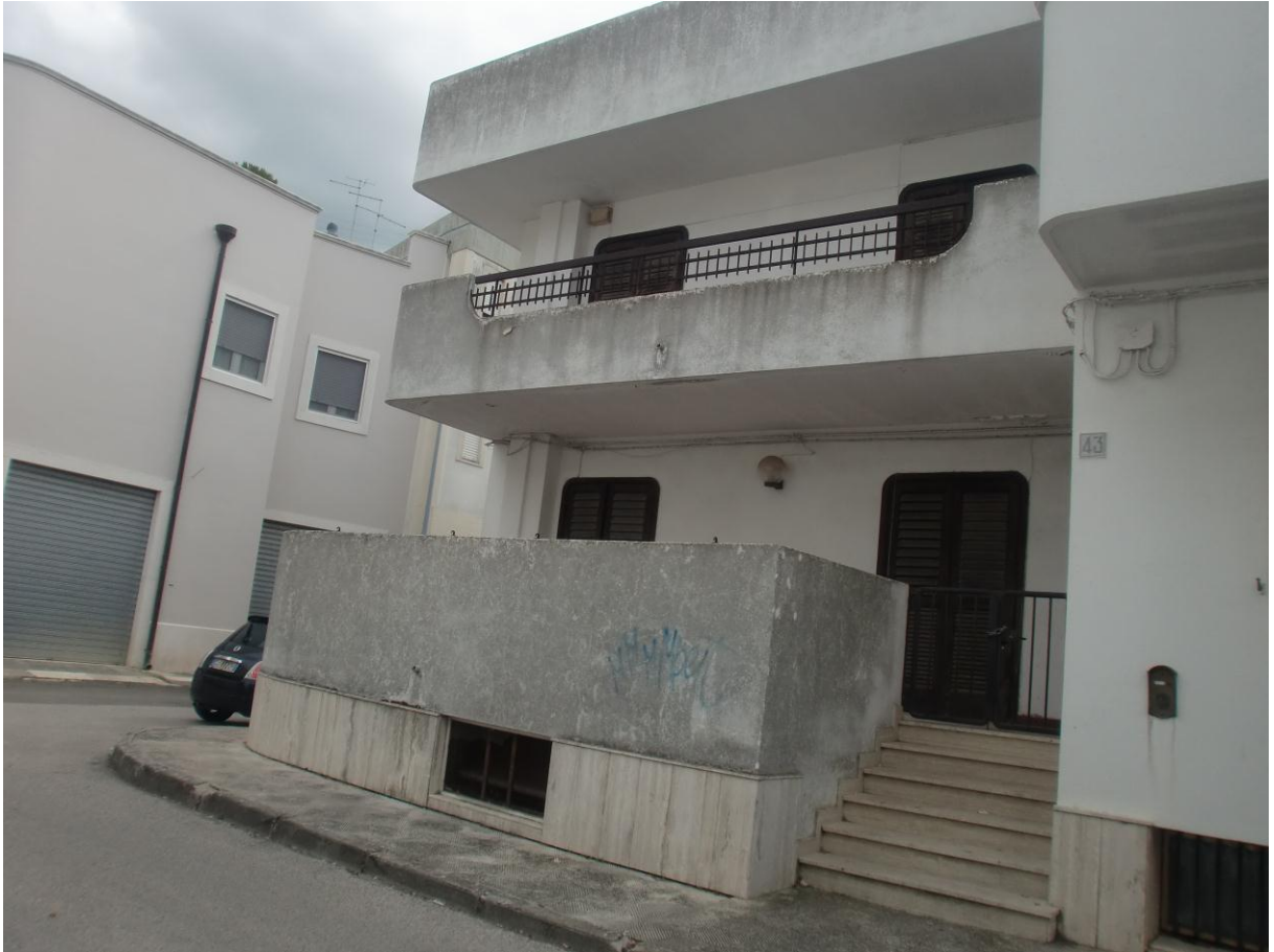
Prospetto principale con accesso ad Est su Via Fonseca
