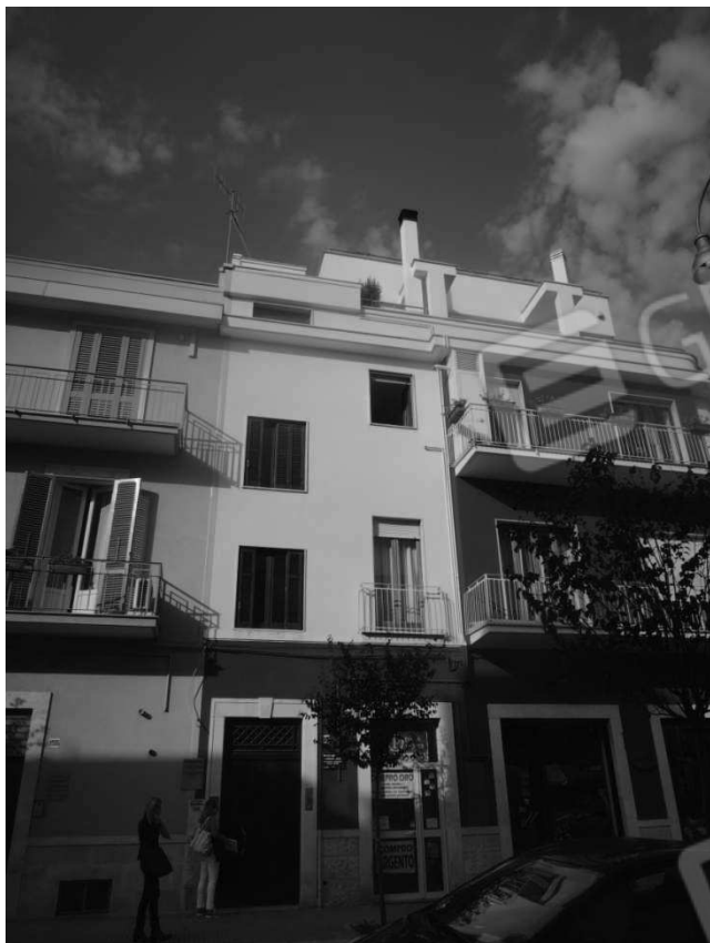
Veduta del prospetto principale del fabbricato
