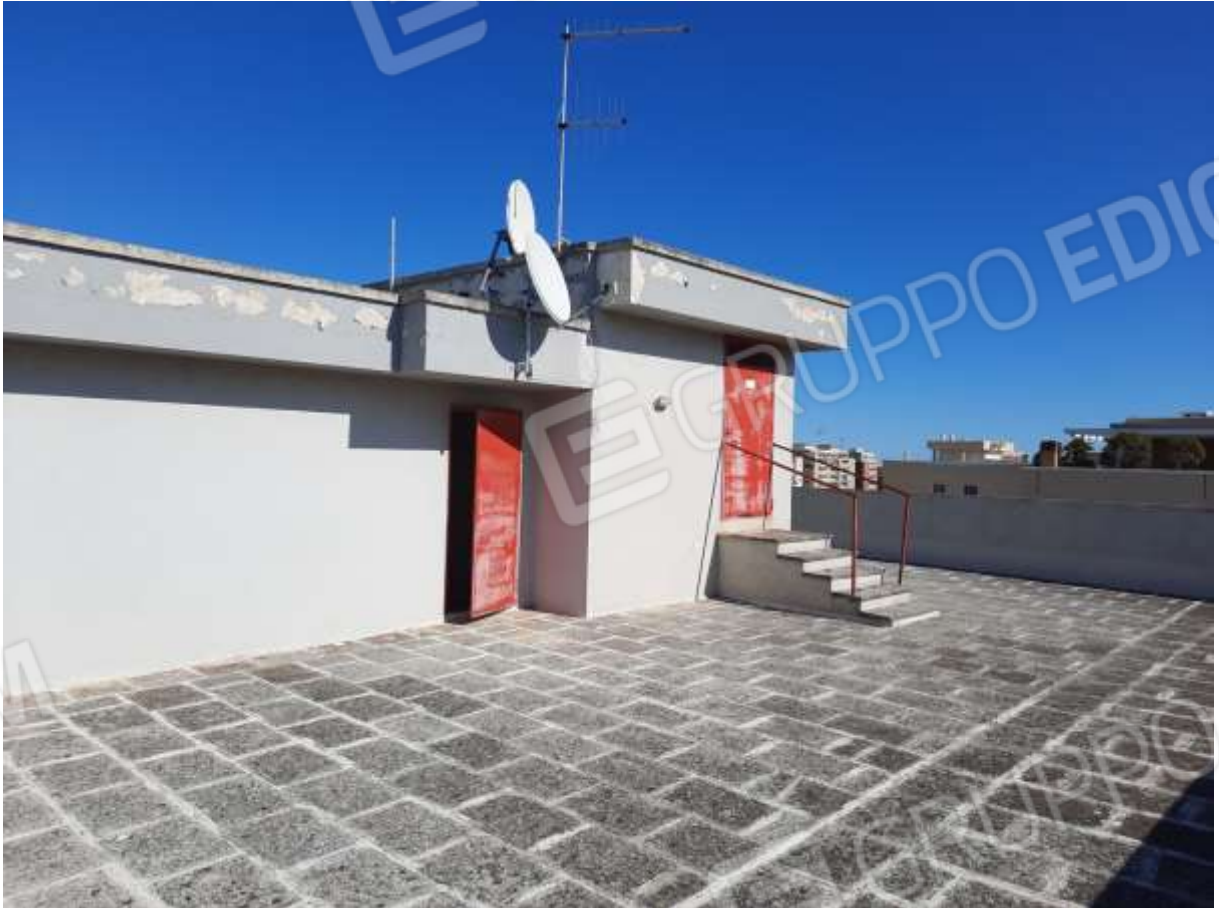
FOTO n° 3. Come foto n° 2. Vista verso la direzione sud.
