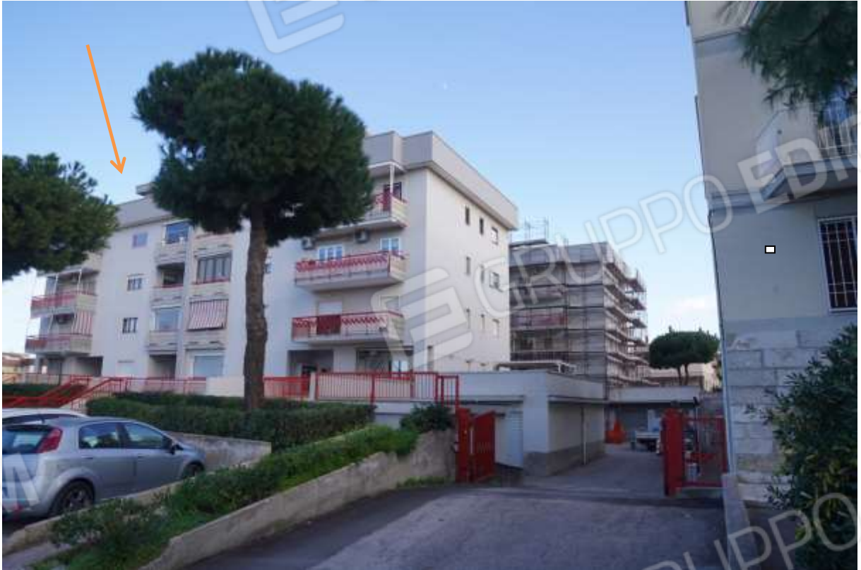
FOTO n° 1. Monopoli. Edificio con accesso dal civico 5 di via F. Raimondi. L'unità immobiliare staggita costituisce il lastrico solare di copertura dell'edificio condominiale pluripiano visibile in primo piano.
