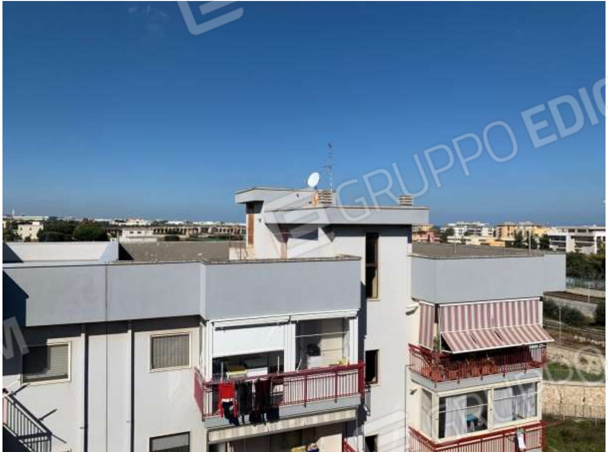
FOTO n° 2. Lastrico solare dell'edificio con accesso dal civico 5 di via Raimondi. Vista complessiva, verso la direzione nord-ovest.
