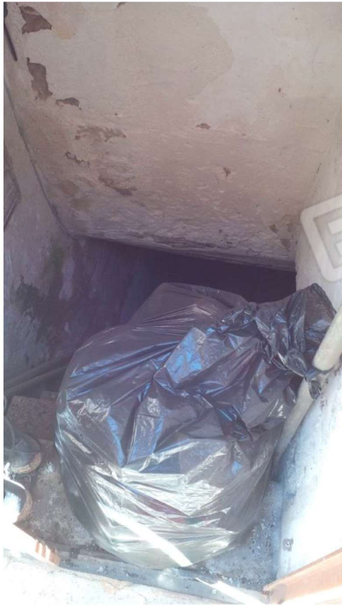
scala di accesso al deposito interrato
