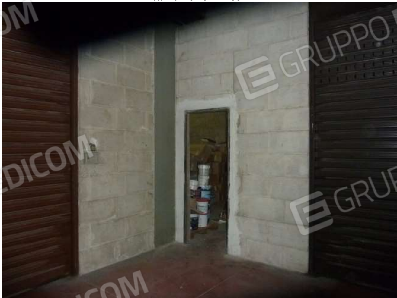
Foto n. 6 – LOTTO N.2– LOCALE
