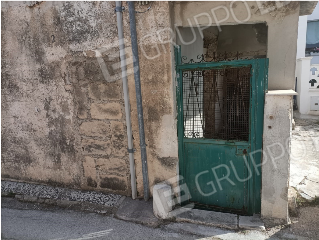
Ingresso piano terra
