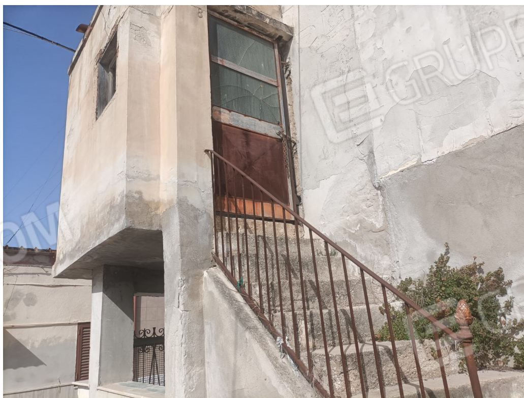
Ingresso primo piano
