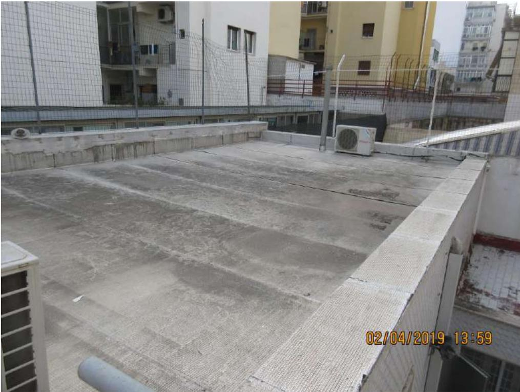
Foto n.77 Impermeabilizzazione della copertura dell'immobile
