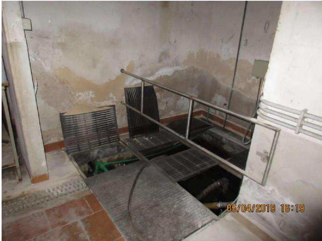
Foto n.55 Pozzo con liquidi e/o reflui delle lavorazioni
