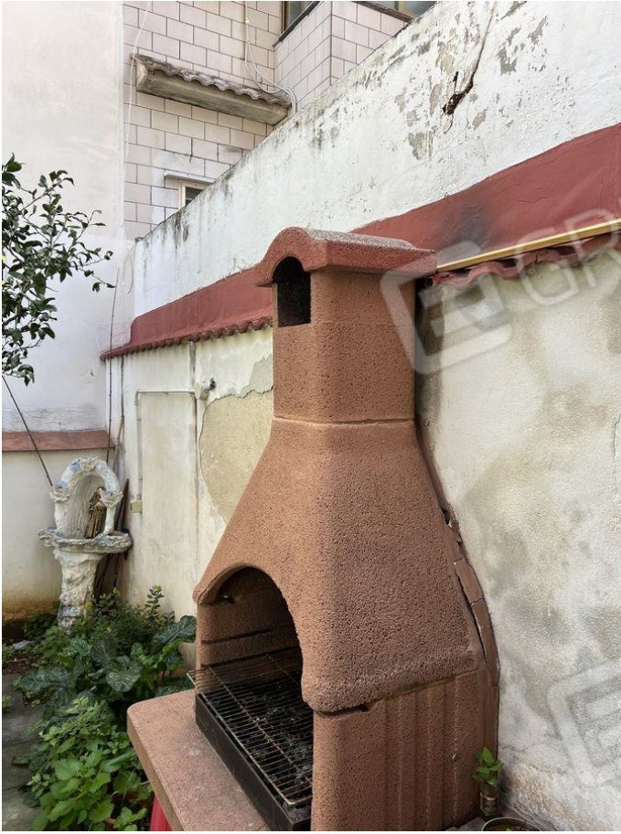
Foto 27 – Vista muro laterale giardino a confine SUD
