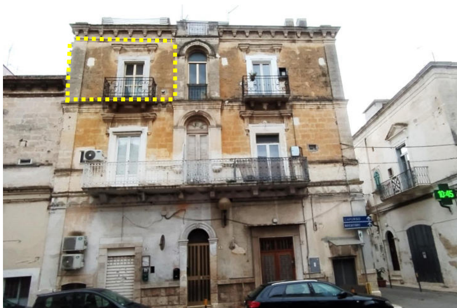
Prospetto principale su via A. Manzoni
