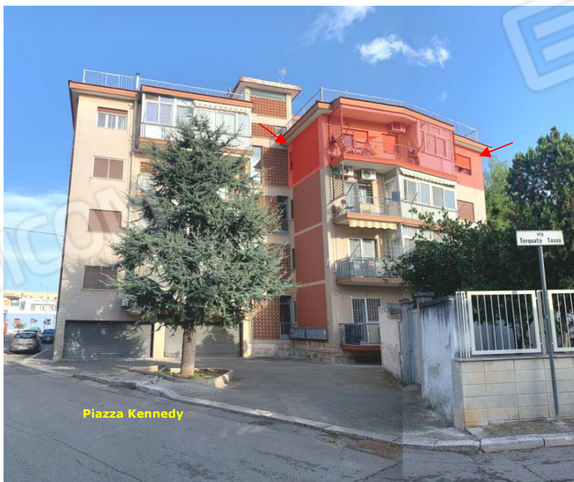
Foto nn. 4-5. Palazzina condominiale
