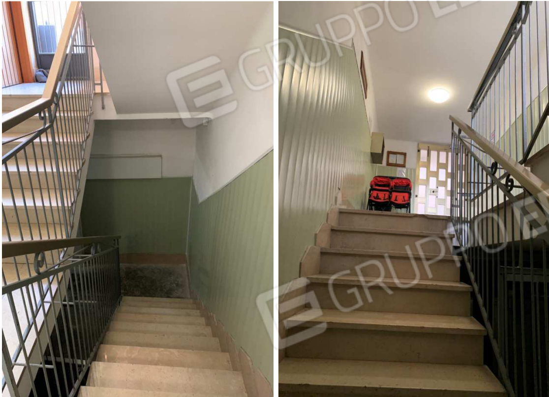
Foto nn. 33-34. Scala di collegamento al piano cantina
