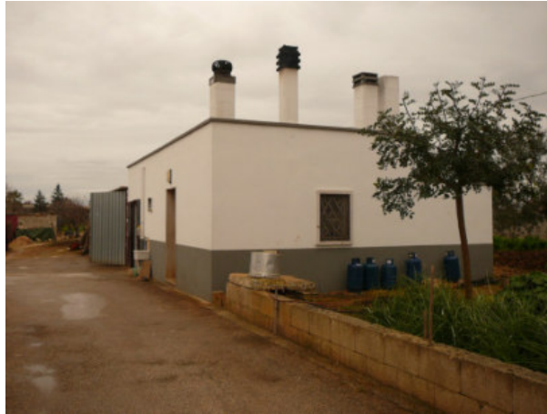
Fabbricato abusivo (corpo B)
