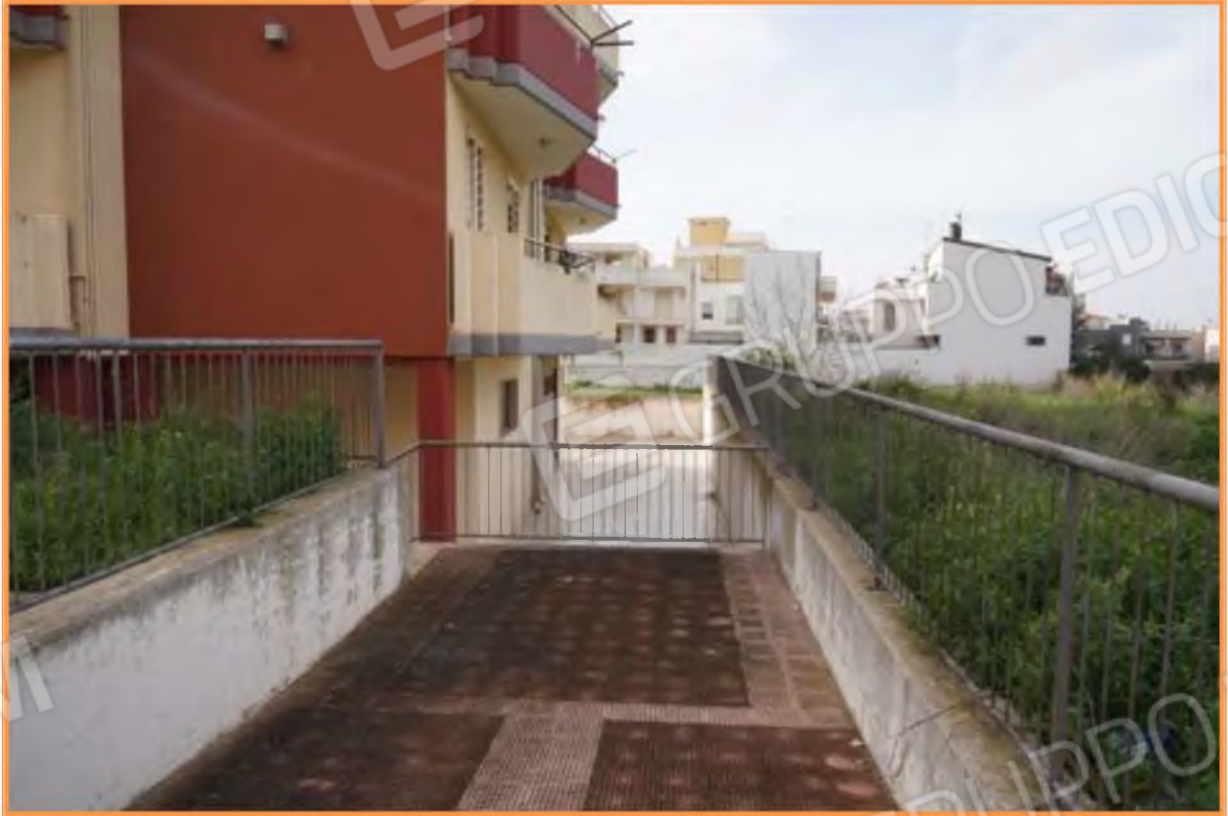
FOTO n° 3. Come foto n° 2. Vista verso la direzione ovest della rampa di accesso al piano seminterrato.
