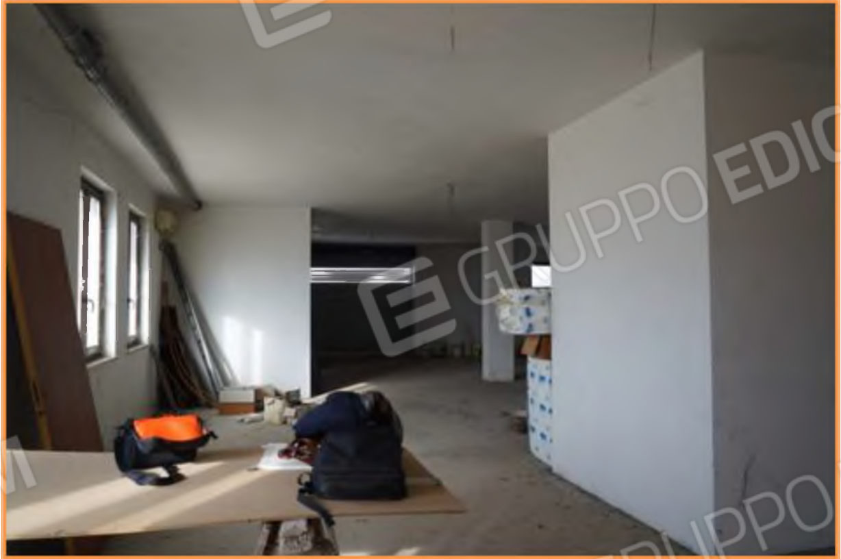
FOTO n° 14. Porzione dell'unità compresa tra il volume ascensore e la muratura di compagno ovest. Vista verso la direzione nord, verso i servizi igienici-blocco n° 2.
