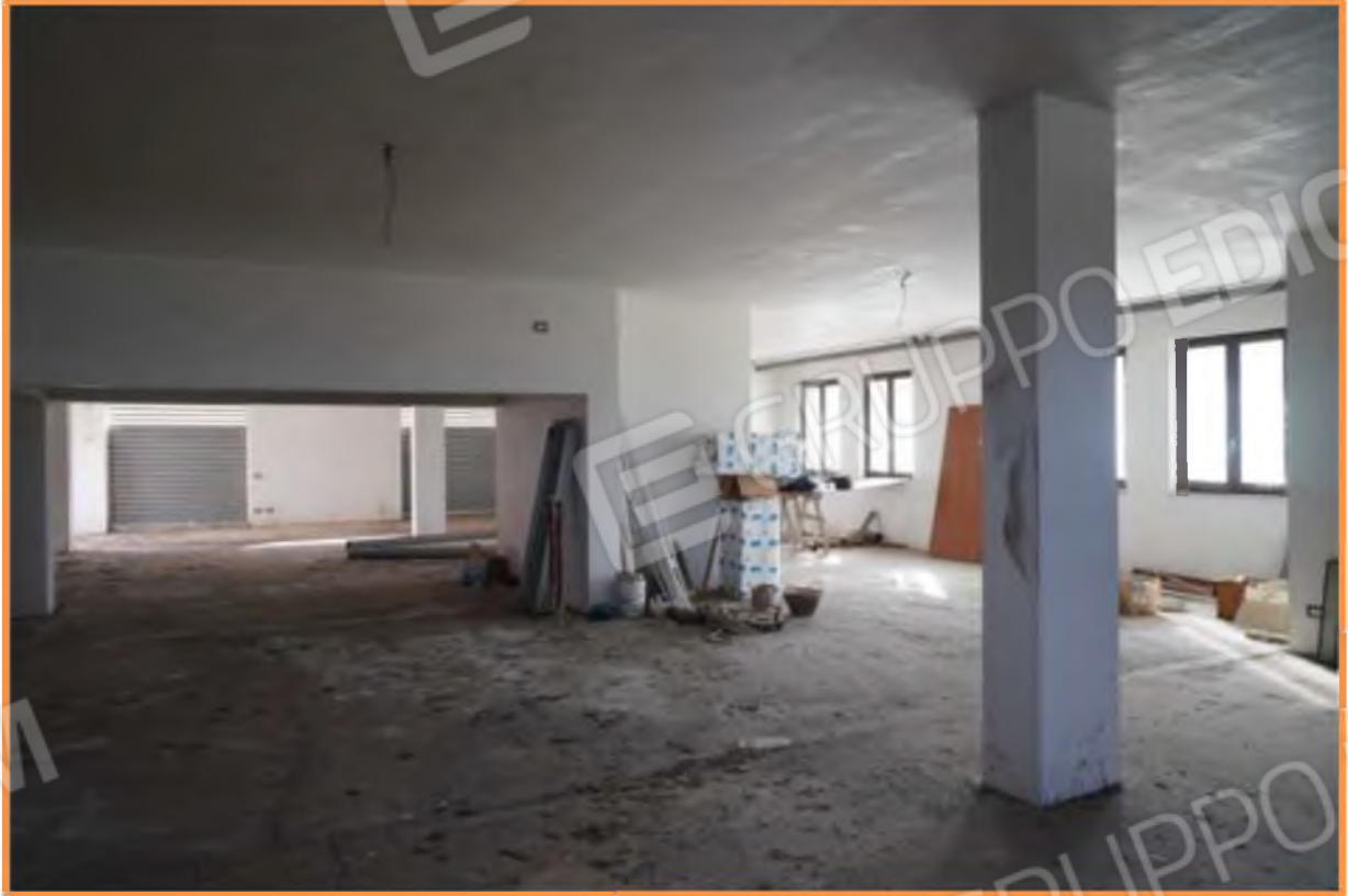
FOTO n° 11. Vista dell'unità seminterrata verso la direzione sud. Le due saracinesche sul fondo si aprono verso l'intercapedine scoperta-veranda a sud. Le finestre si aprono sulla rampa scoperta che immette al piano interrato.
