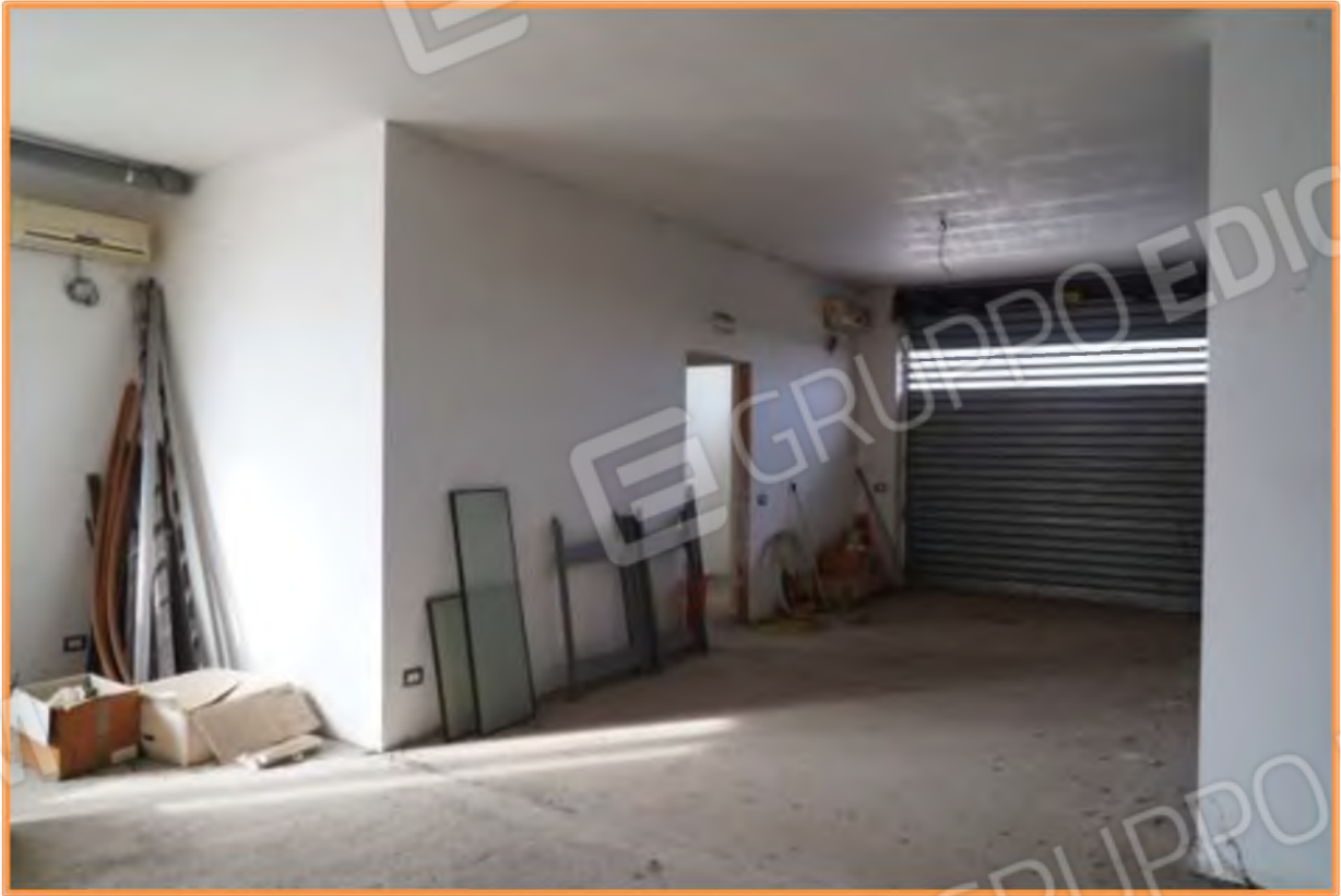
FOTO n° 13. Vista verso la direzione nord. A sinistra è visibile l'unità servizi igienici-blocco n° 2. La saracinesca visibile in posizione frontale si apre sullo spazio veranda-intercapedine scoperta nord.
