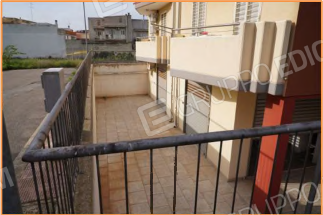
FOTO n° 6. Come foto n° 5, vista del corridoio distributore a livello seminterrato nella parte in cui risvolta lungo il prospetto sud dell'edificio. Le saracinesche afferiscono alle aperture dell'unità staggita. A sinistra è visibile [REDACTED]
