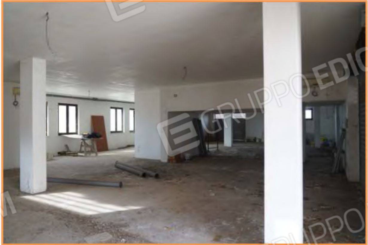
FOTO n° 10. Vista dell'unità seminterrata verso la direzione nord. La saracinesca sul fondo si apre verso l'intercapedine scoperta-veranda a nord. Le finestre si aprono sulla rampa scoperta che immette al piano interrato.
