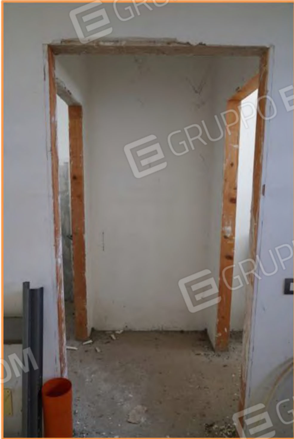
FOTO n° 20. Disimpegno dei servizi igienici-blocco n° 2 I w.c. sono posizionati sui due lati.
