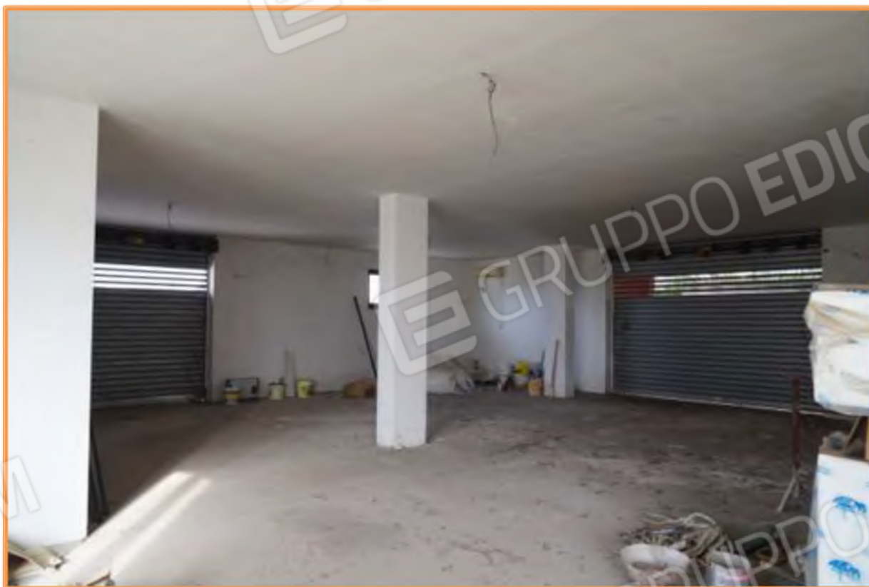
FOTO n° 12. Vista dell'unità seminterrata verso la direzione nord-est. La saracinesca a sinistra si apre verso l'intercapedine scoperta-veranda a nord. La saracinesca a destra si apre verso l'intercapedine est che è il distributore principale al piano seminterrato dopo essere scesi dalla rampa di ingresso posta sulla [REDACTED]
