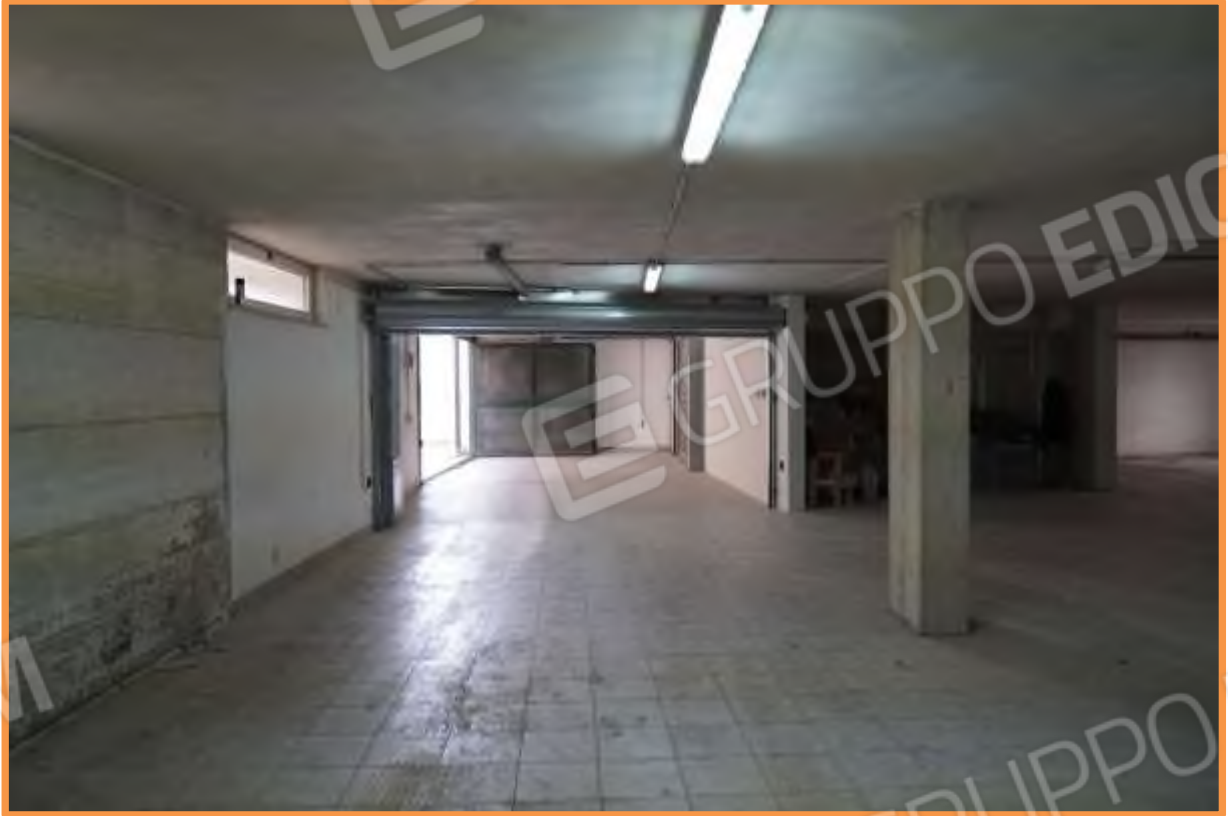
FOTO n° 7. Come foto n° 6. Vista nella direzione opposta verso sud-ovest, verso l'entrata e il disimpegno comune.
