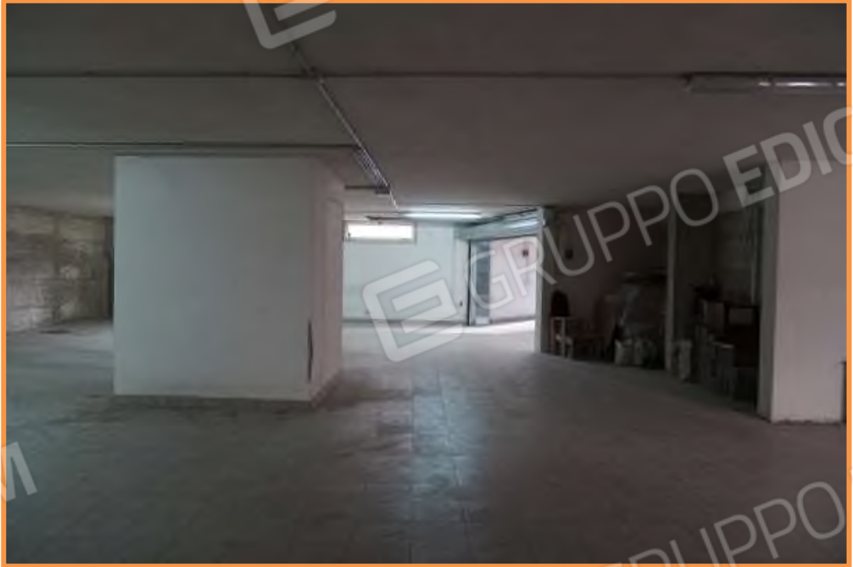
FOTO N° 14 Vista generale dell'interno del deposito verso la direzione sud-est.
