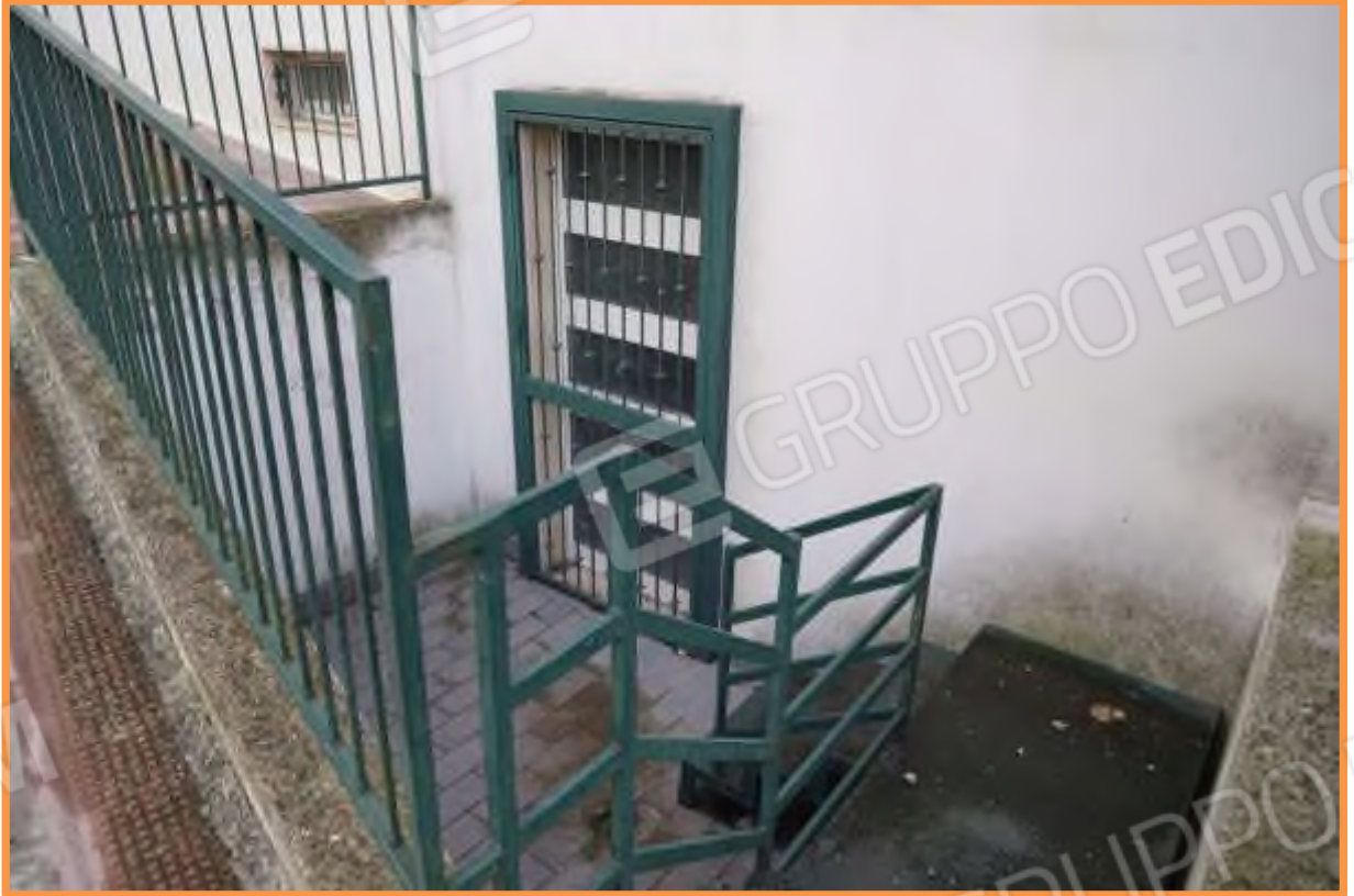
FOTO n° 4. Come foto n° 3, particolari.
