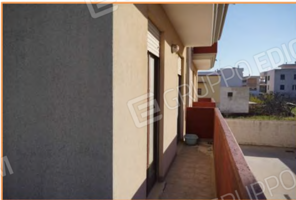
FOTO n° 16. Come foto n° 15, vista verso la direzione sud.
