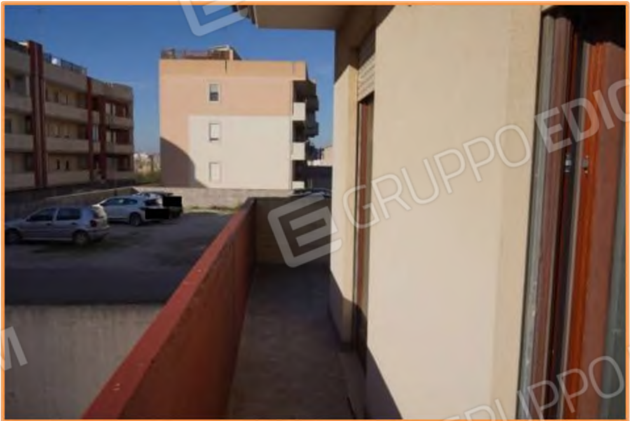
FOTO n° 15. Balcone a ovest di pertinenza delle due camere. Vista verso la direzione nord.
