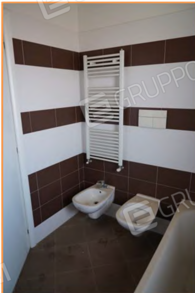
FOTO n° 12. Vano bagno, vista verso la direzione sud-ovest.
