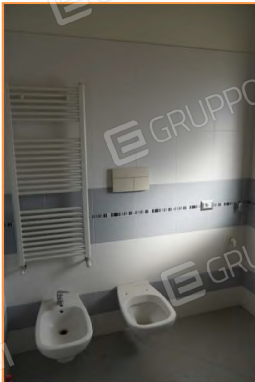
FOTO n° 12. Vano bagno, vista verso la direzione sud-est.
