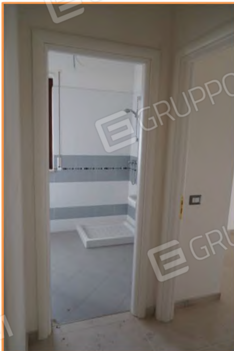
FOTO n° 11. Vano bagno, vista verso la direzione sud-ovest.
