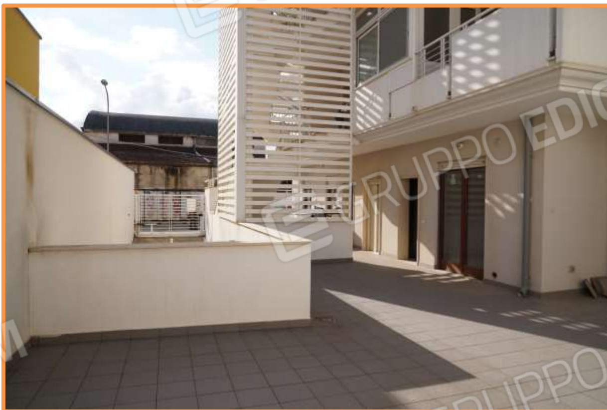
FOTO n° 14. Come foto n° 13, vista verso la direzione sud. La terrazza a livello si delinea tra il parapetto che separa dalla rampa di discesa al piano interrato ed il corpo scala condominiale “open”
