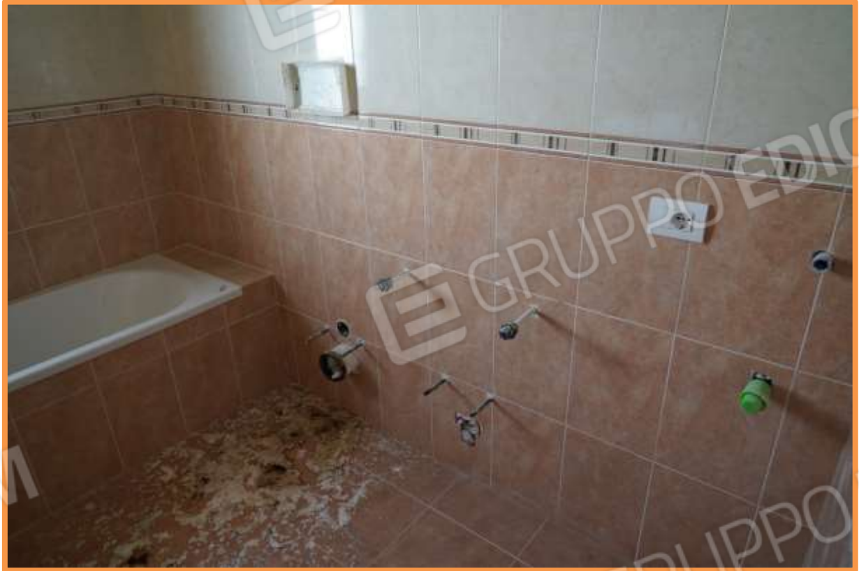
FOTO n° 11. Vano bagno, vista verso la direzione sud-est. Particolare delle predisposizioni per il collegamento dei sanitari e altri complementi di arredo.
