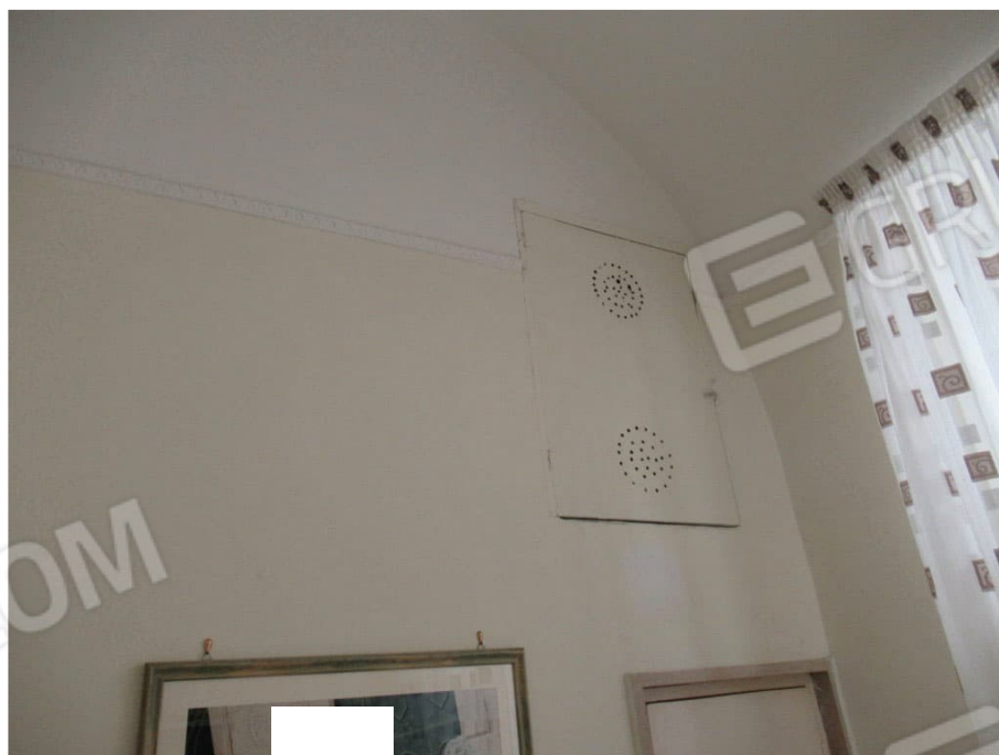
Ingresso – Vista ammezzato su bagno
