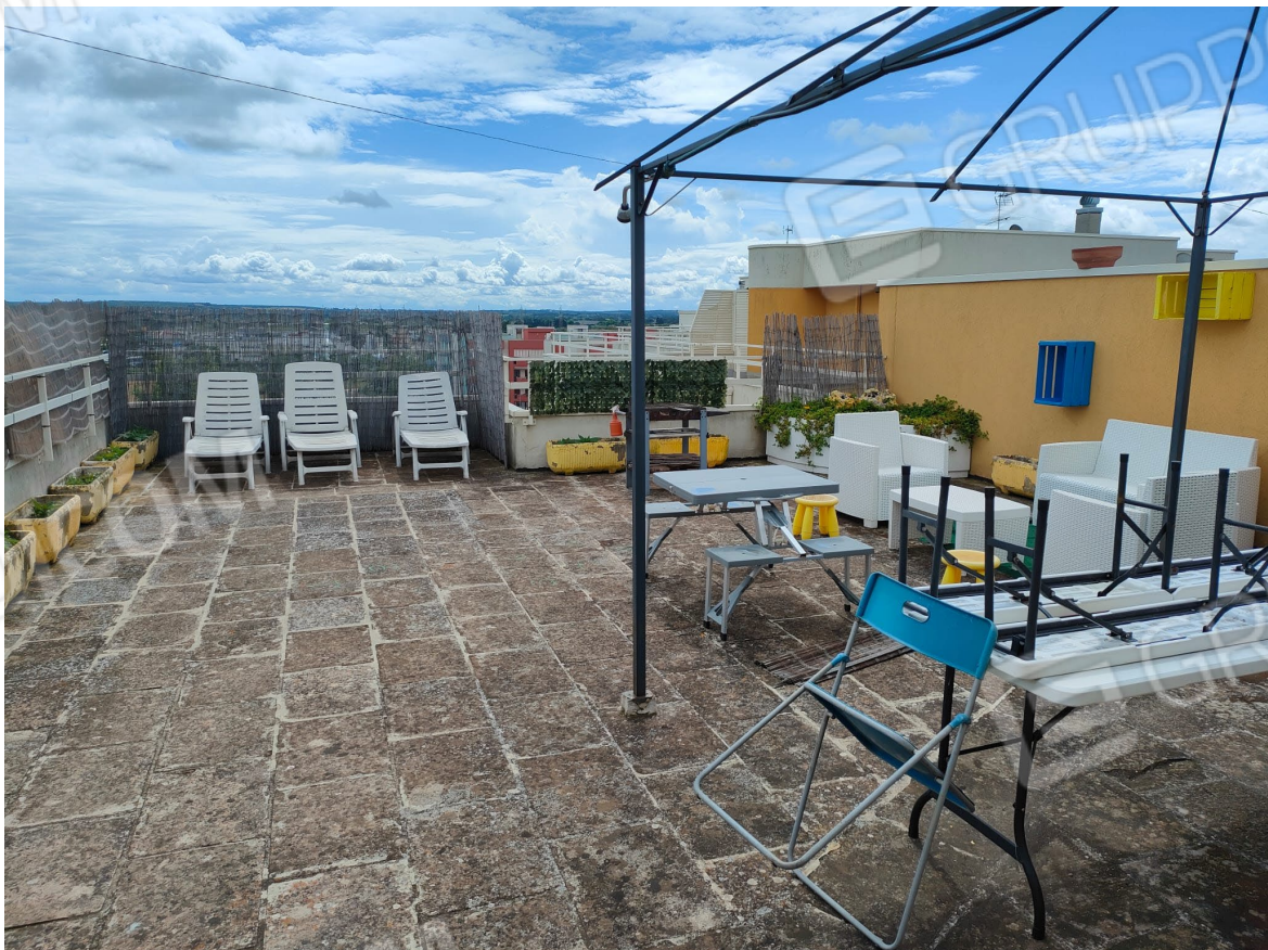
Foto n.14: vista lastrico solare.
