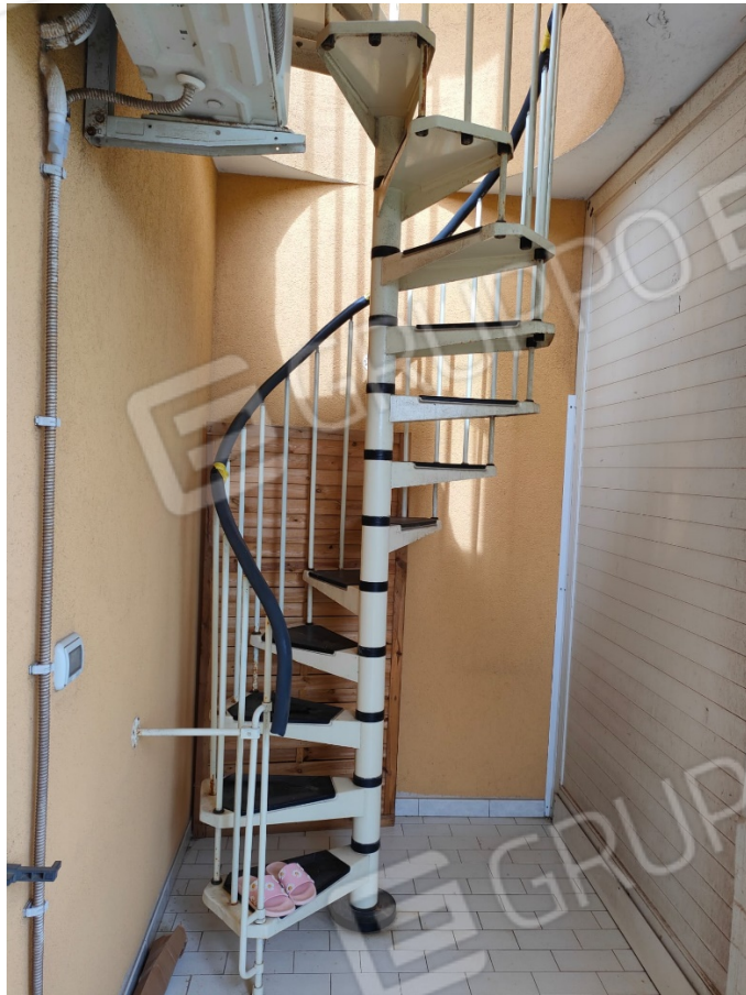
Foto n.13: vista scala esterna.
