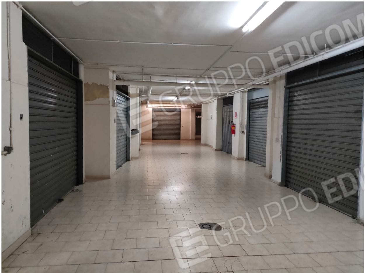
Foto n.3: vista spazio di manovra.
