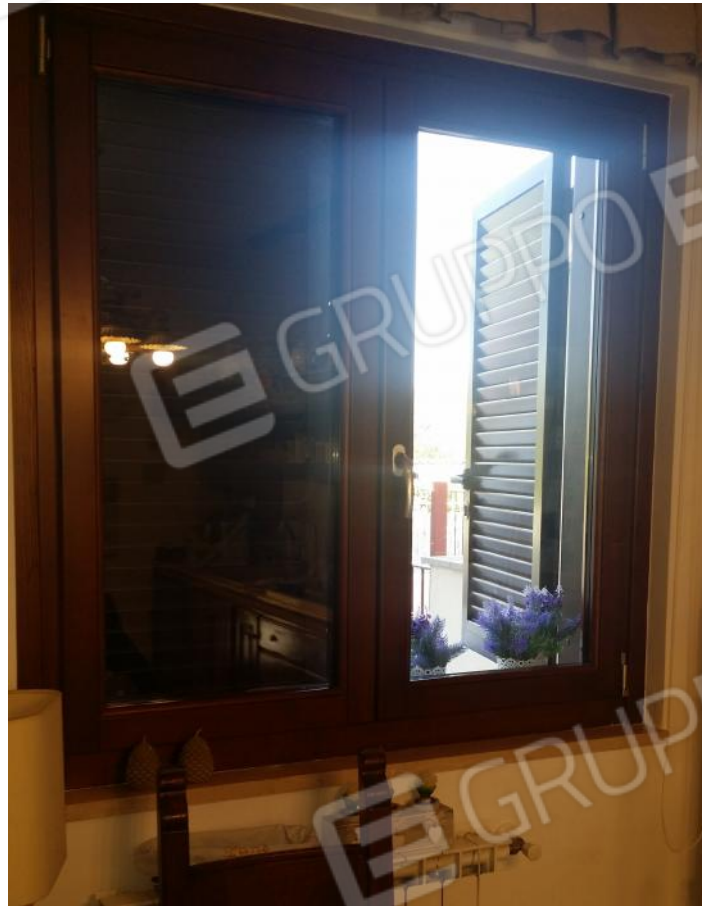
FOTO N. 15 - FINESTRA NEL VANO CUCINA, PIANO RIALZATO
