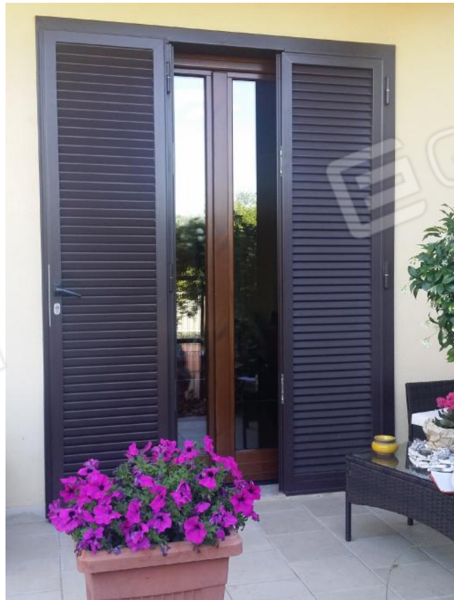
FOTO N. 4 - BALCONE ANTISTANTE PIANO RIALZATO
