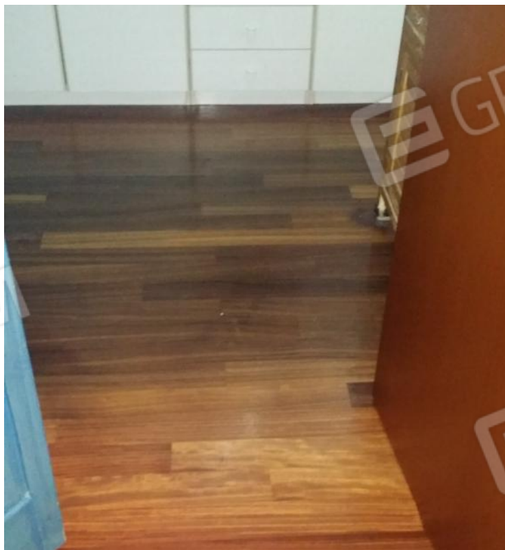
FOTO N. 18 - VANO LETTO 2, PIANO PRIMO
