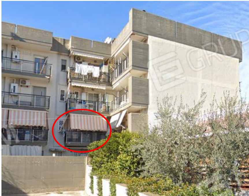
Foto n.2: Prospetto secondario dell'edificio, ripreso dalla via Sciarra, con evidenziazione dell'immobile in oggetto.
