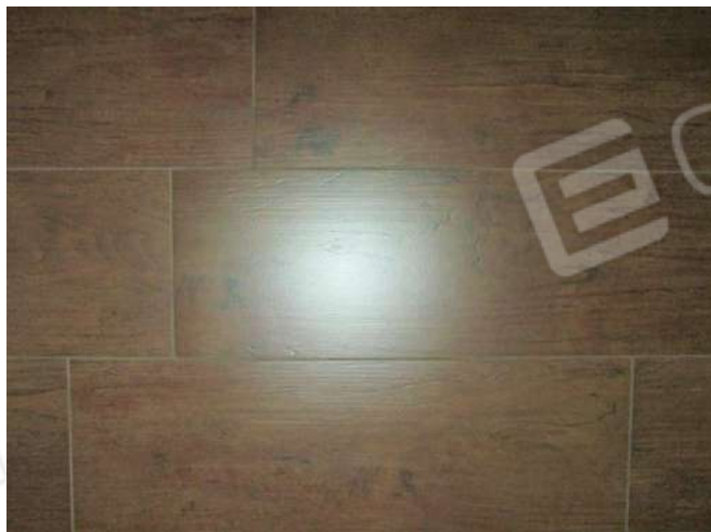
Foto 33 - Particolare pavimentazione interna dell'appartamento
