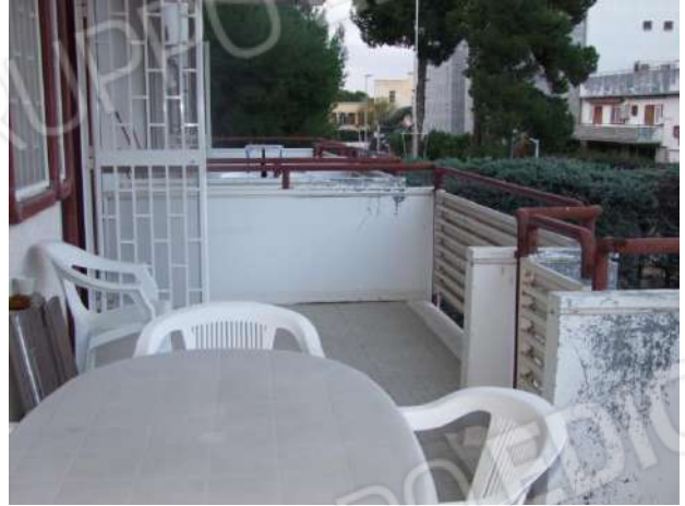
Foto 30 – Vista verso il lato Nord - Ovest
