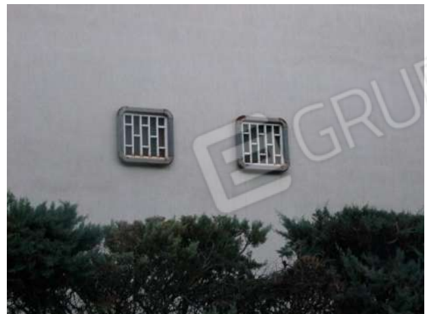
Foto 10 - Prospetto laterale - Particolare finestre del Bene
