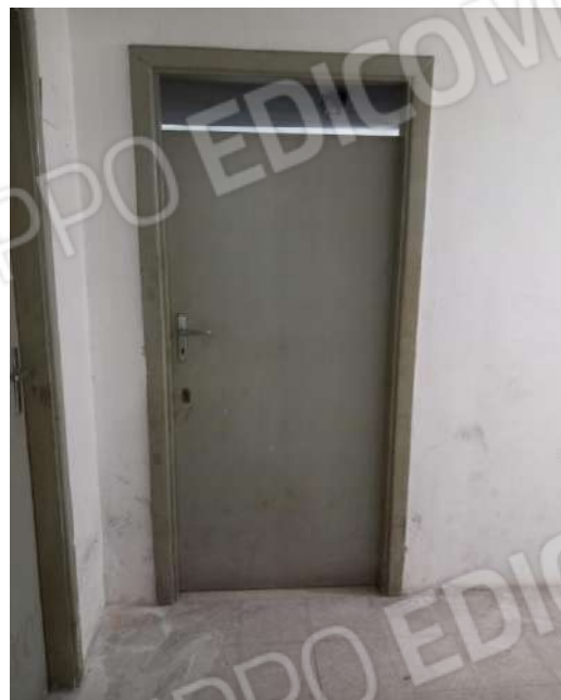
Foto 45 - Vista della porta d'ingresso
