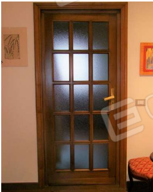
Foto 39 - Particolare infisso interno
