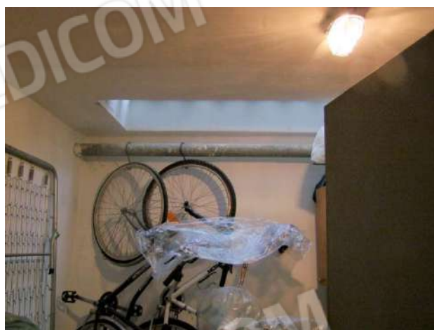
Foto 47 - Vista interna - Particolare lucernario al soffitto
