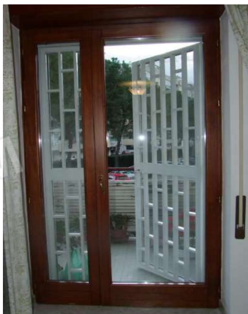
Foto 41 e 42 - Particolare infissi esterni
