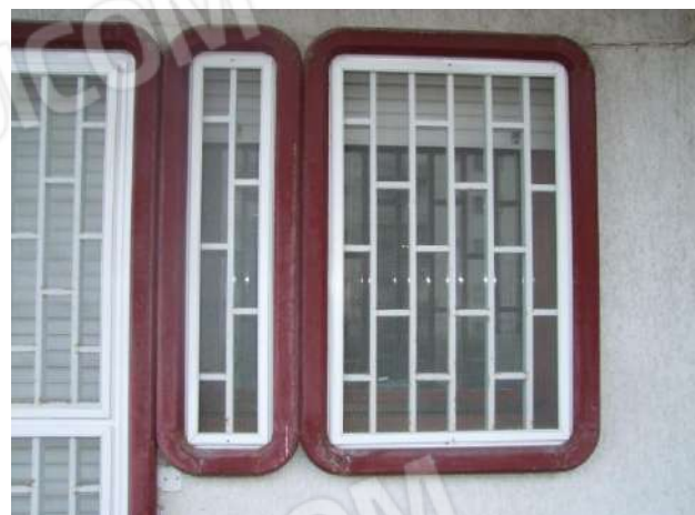
Foto 43 - Particolare infisso esterno - vista esterna
