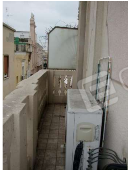
Foto 41 - Vista della balconata al prospetto su via S. Bartolomeo
