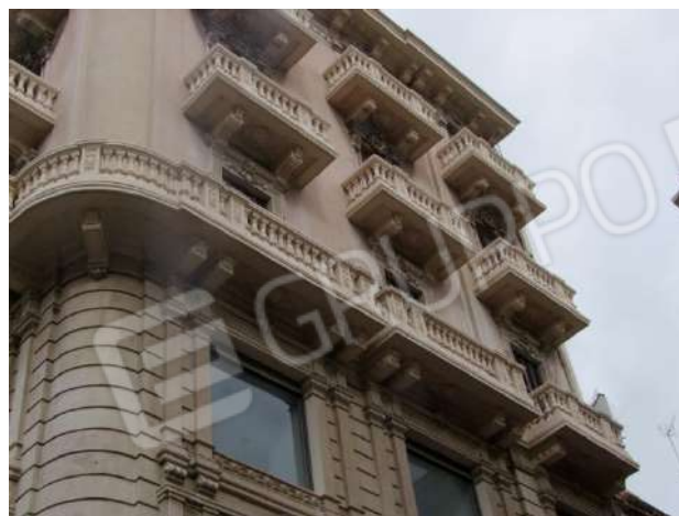
Foto 4 – Prospetto su via Roberto Il Guiscardo - Particolare balconi al piano terzo
