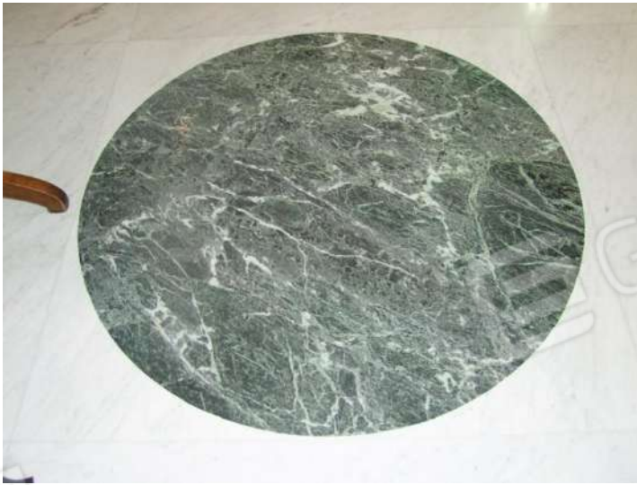
Foto 48 - Particolare decoro a pavimento nel disimpegno 1
