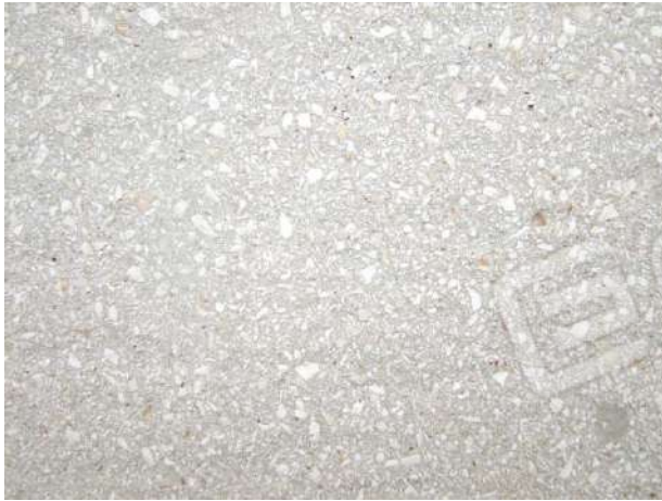
Foto 42 - Particolare muratura dei prospetti
