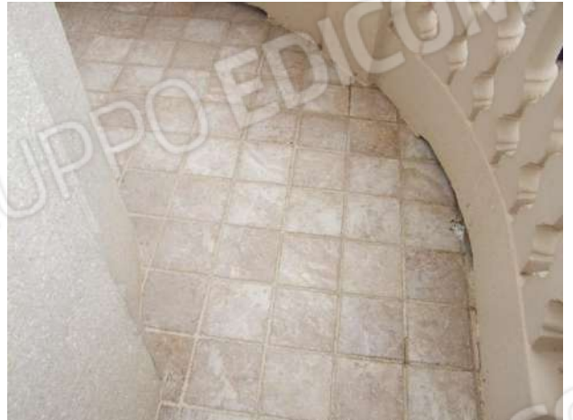
Foto 43 - Particolare zona in angolo delle balconate
