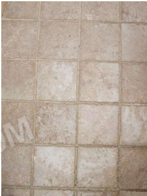
Foto 44 - Particolare pavimentazione balconi
