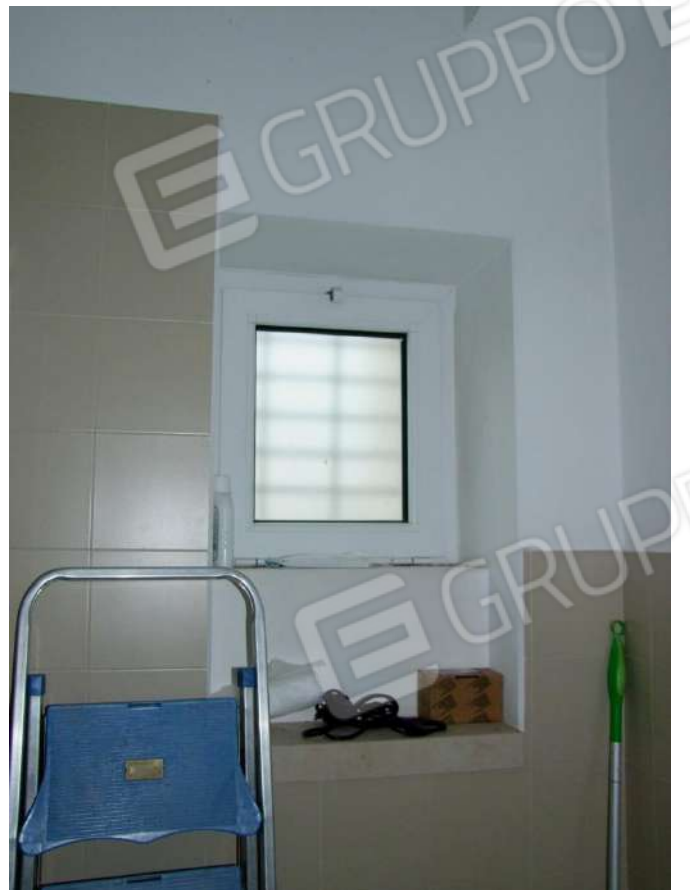
Foto 59 - Particolare infisso del bagno WC5
