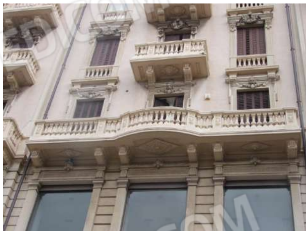
Foto 5 – Particolare balconata centrale al piano terzo - prospetto su largo Chiurlia
