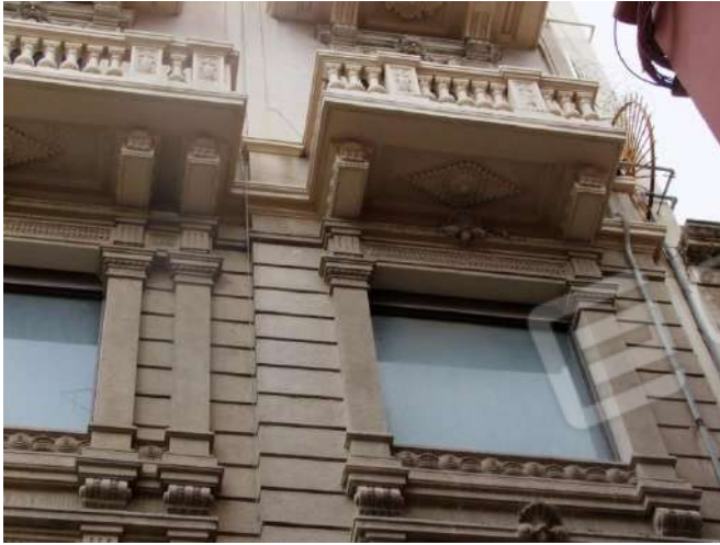
Foto 7 e 8 – Particolari intradossi delle solette dei balconi
