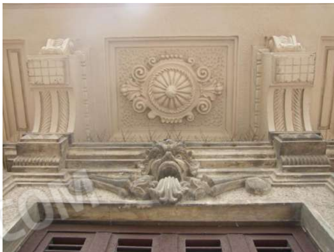
Foto 9 – Particolare decorazione dell'architrave delle finestre e all'intradosso delle solette sovrastanti
