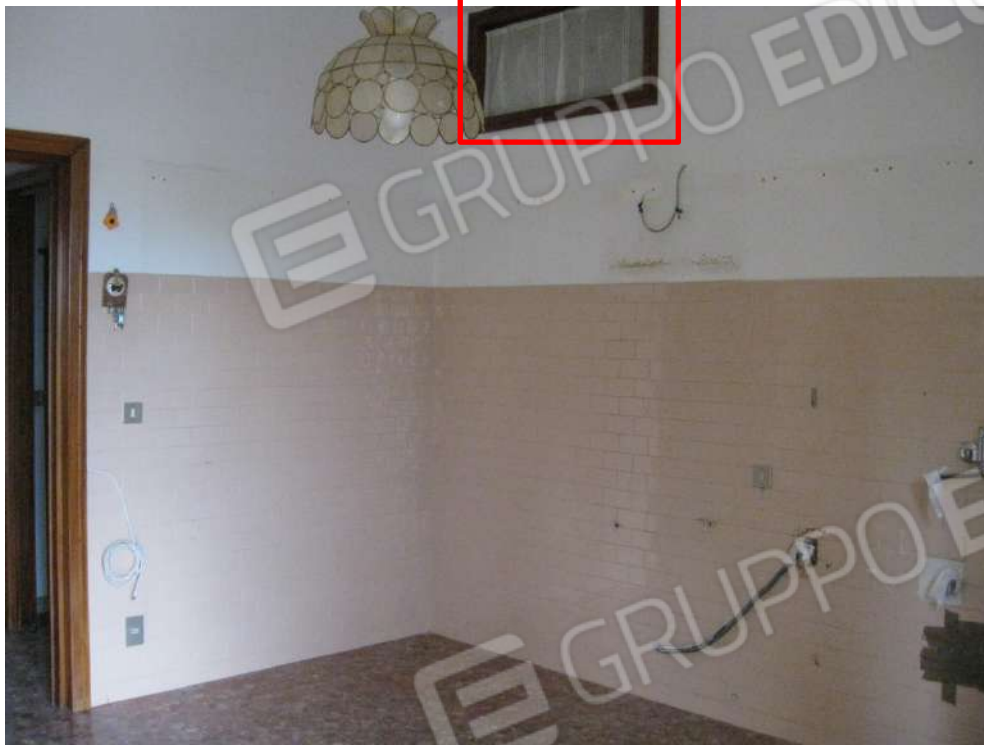
Foto 17: Particolare del finestrino che si apre nel vano ripostiglio
