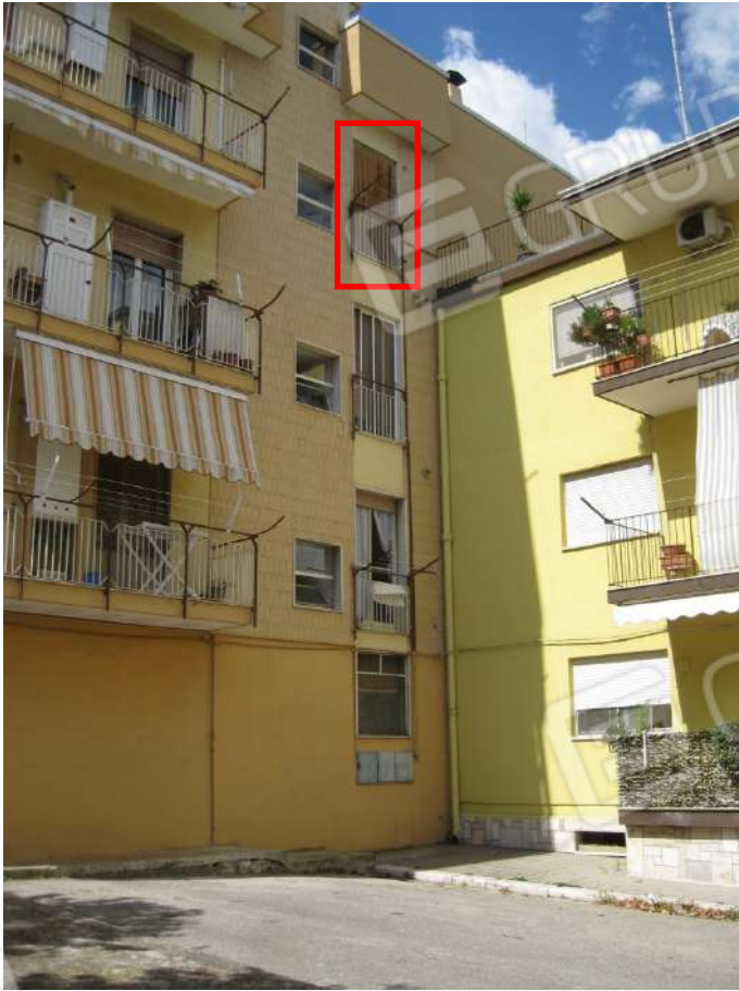
Foto 5: Prospetto nord-est con indicazione della porta-finestra della cucina
