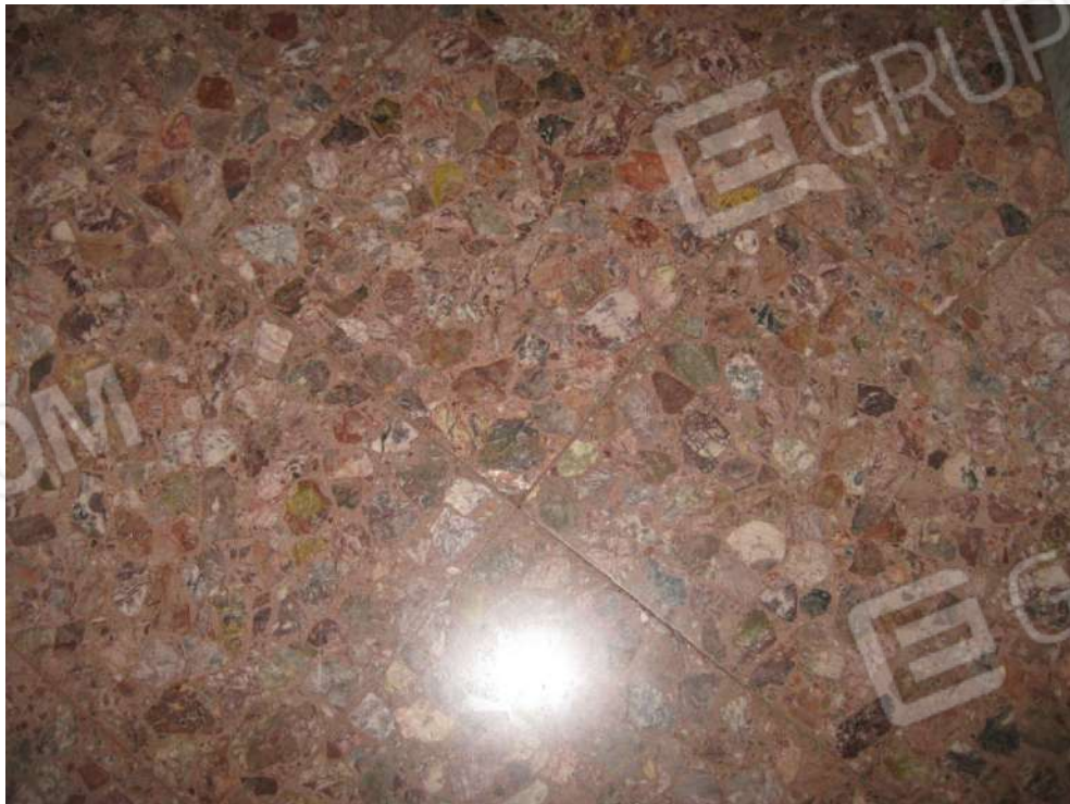
Foto 12: Particolare delle piastrelle del pavimento presente in tutte le stanza dell'appartamento, ad eccezione del bagno
