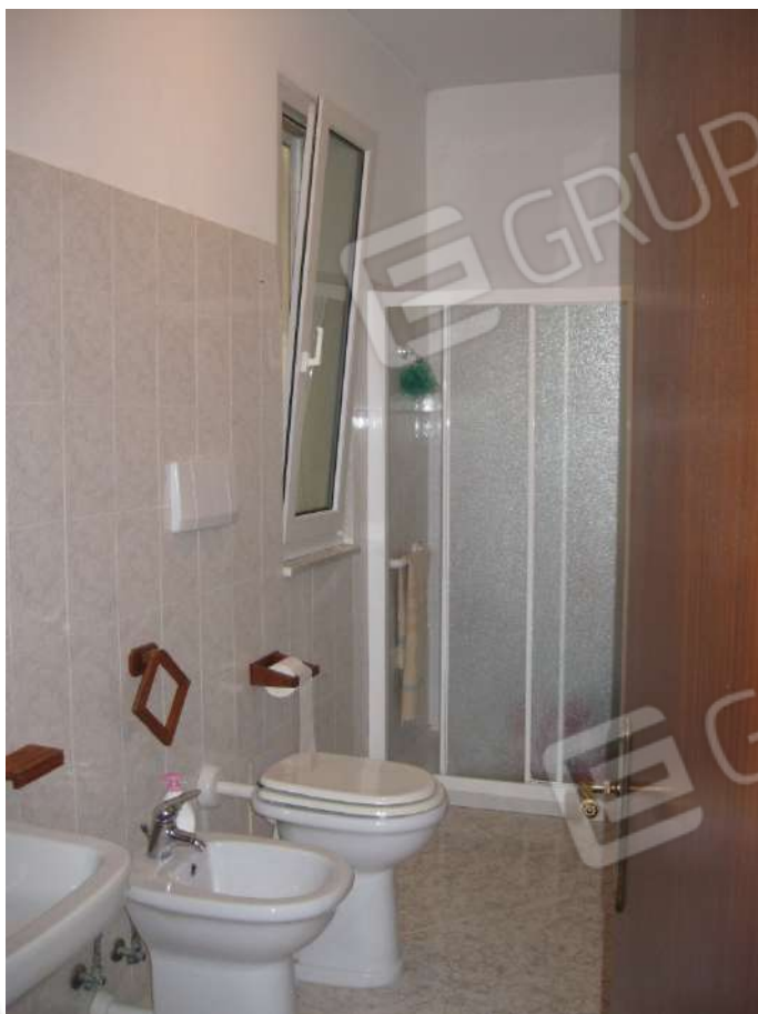
Foto 27: Particolare del servizio igienico. Si può notare come il bagno sia sotto sottoposto ad una ristrutturazione in tempi recenti. Si possono notare i sanitari in ceramica, il box doccia in acrilico e le piastrelle del pavimento diverse dal resto dell'appartamento e il rivestimento
