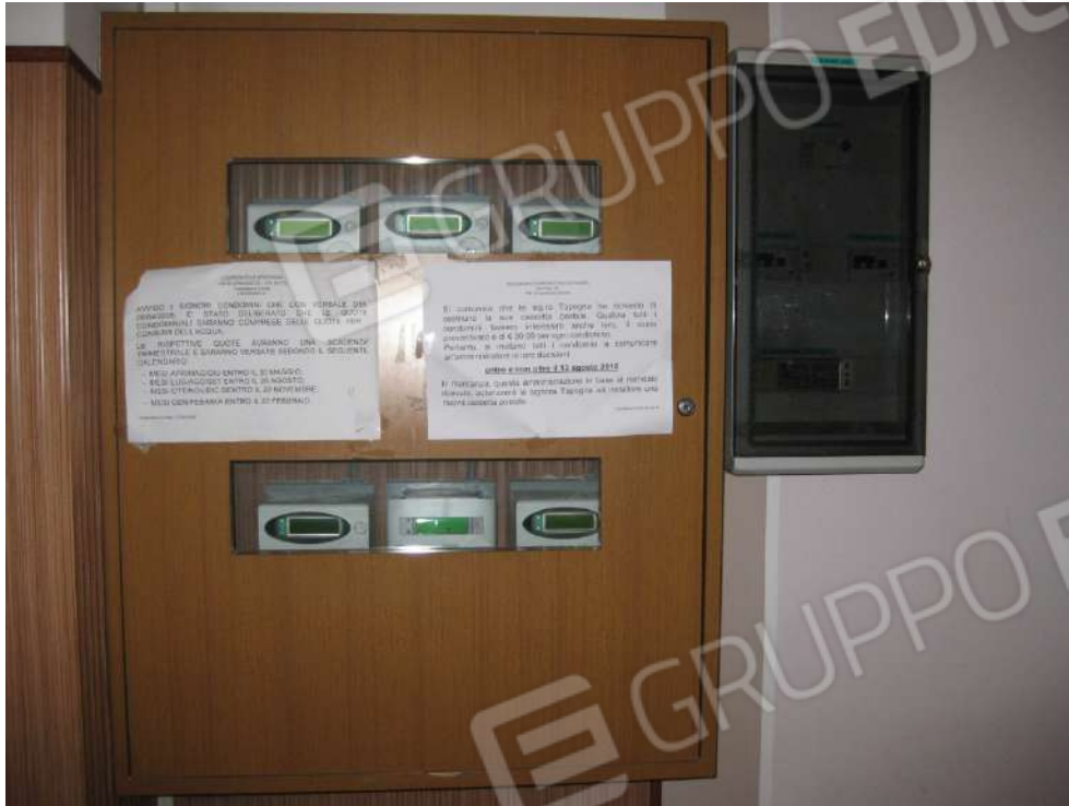
Foto 7: Armadietto a protezione dei contatori delle varie unità immobiliari
