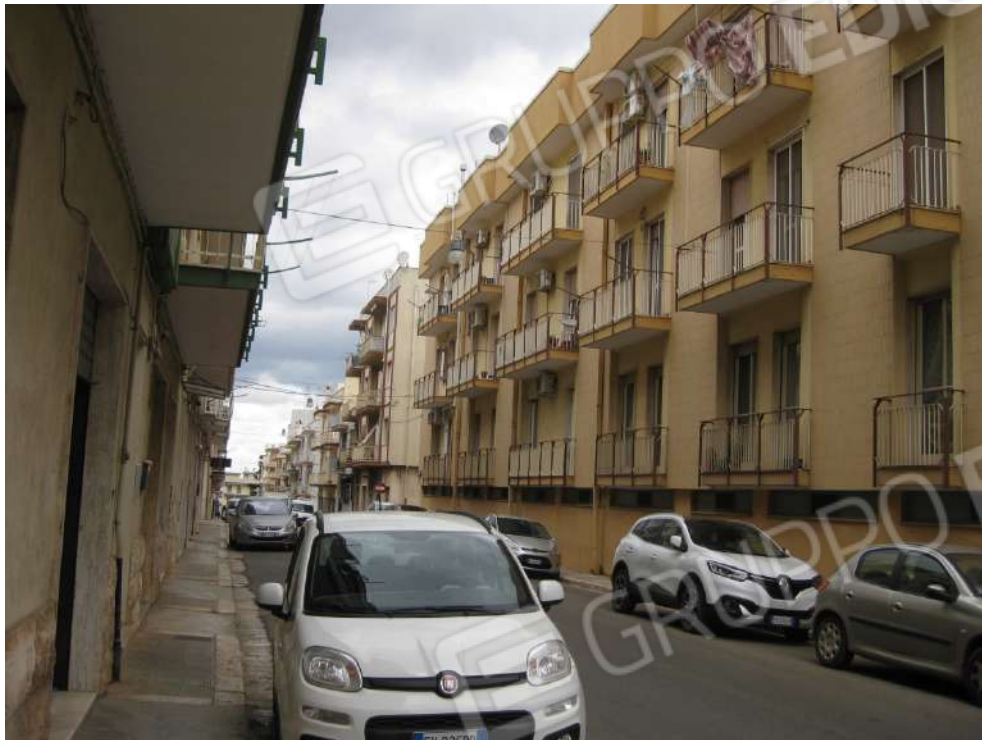
Foto 3: Prospetto complesso condominiale su via Giambattista Vico (vista da via Vincenzo Fato)
