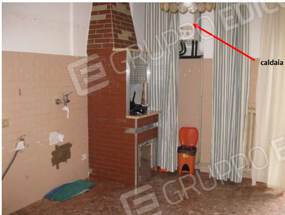
Foto 15: Cucina, posta a destra rispetto all'ingresso. Si possono notare il caminetto a legna e la caldaia installata per il riscaldamento e per la produzione di acqua calda sanitaria
