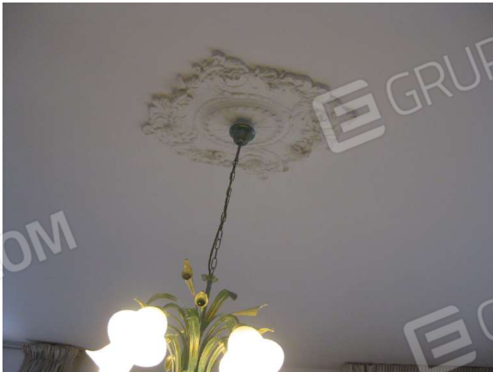
Foto 42: Particolare di un rosone in gesso a soffitto posto in corrispondenza dei lampadari
