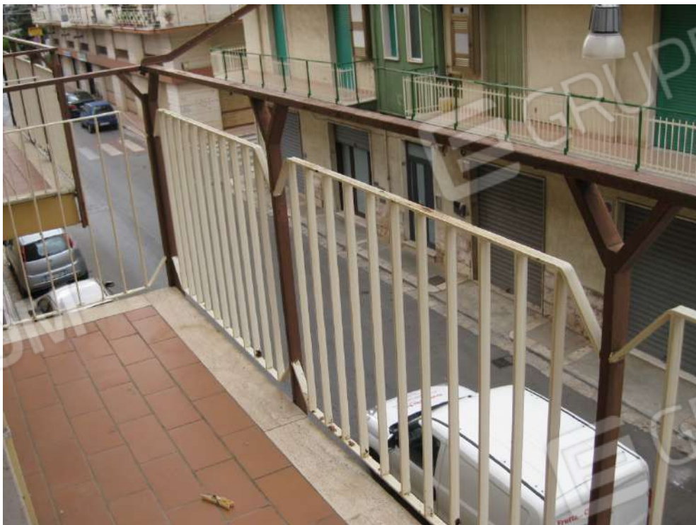
Foto 34: Particolare del balcone comune alle due camere da letto
