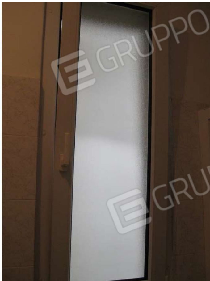
Foto 28: Particolare dell'infisso all'interno del bagno
