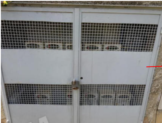
Foto n. 35 Quadro contatori del condominio (residence) chiuso con lucchetto, ubicato sul vialetto di accesso
