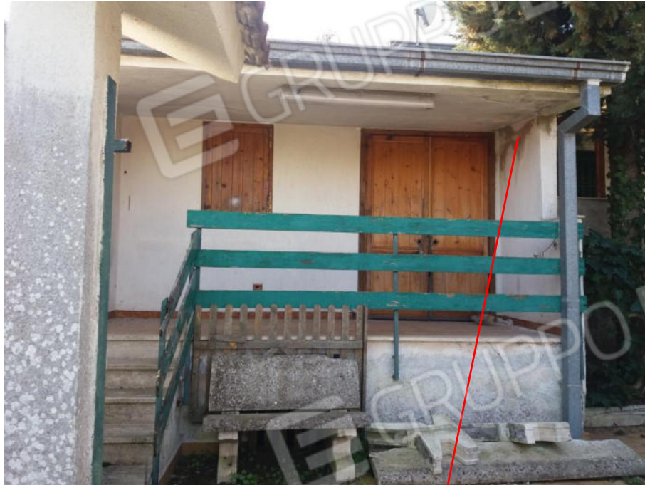
Foto n. 10 Ingresso da veranda rialzata
