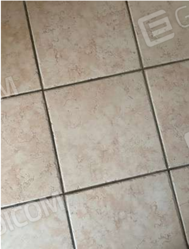
Pavimentazione piano terra
