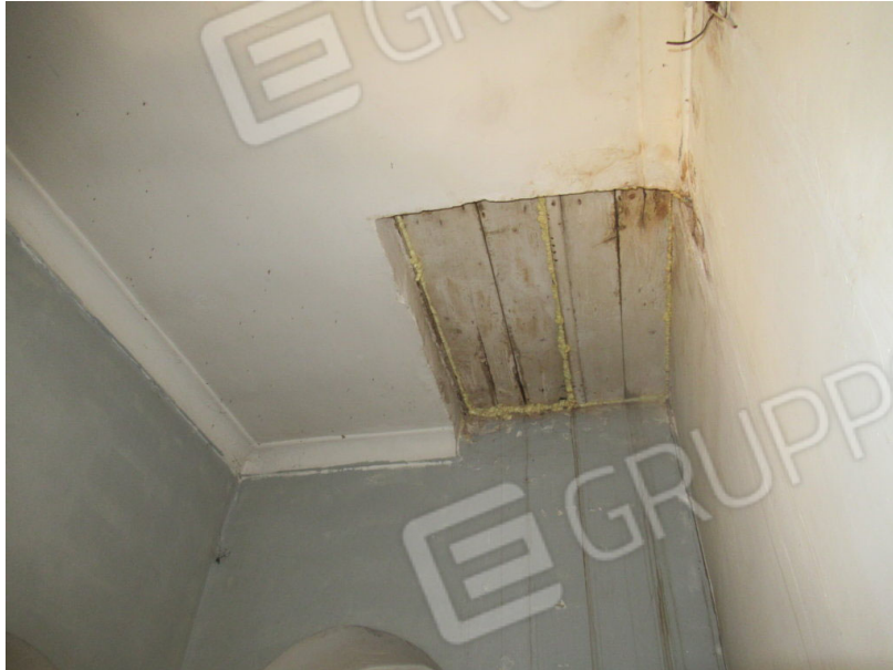
PIANO PRIMO – DISIMPEGNO – BOTOLA PER SOFFITTA
