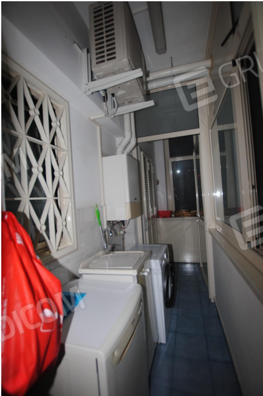
Foto 27: Ripresa del balcone-veranda ad est sul cortile interno.
