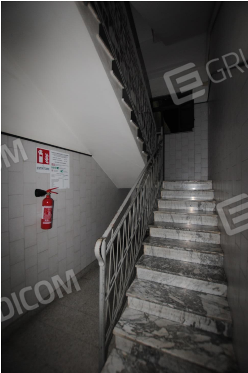
Foto 7: Ripresa delle scale del fabbricato.
