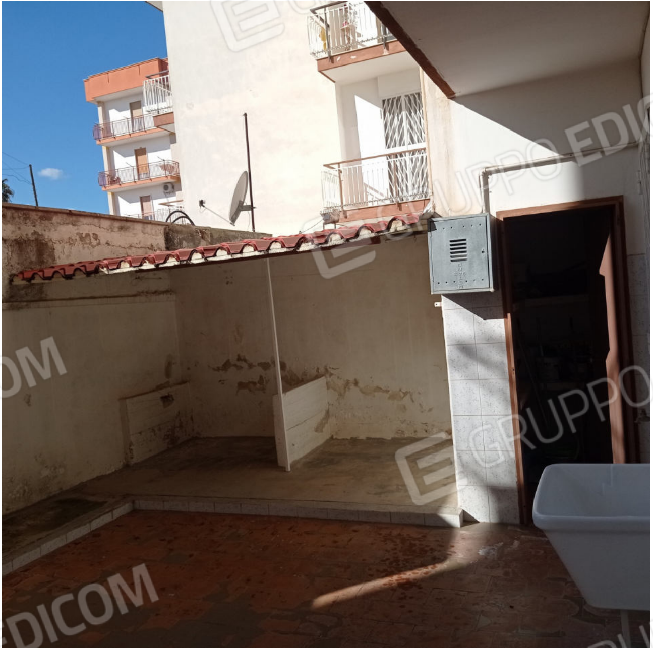
foto14) dettaglio confine parete lato est
