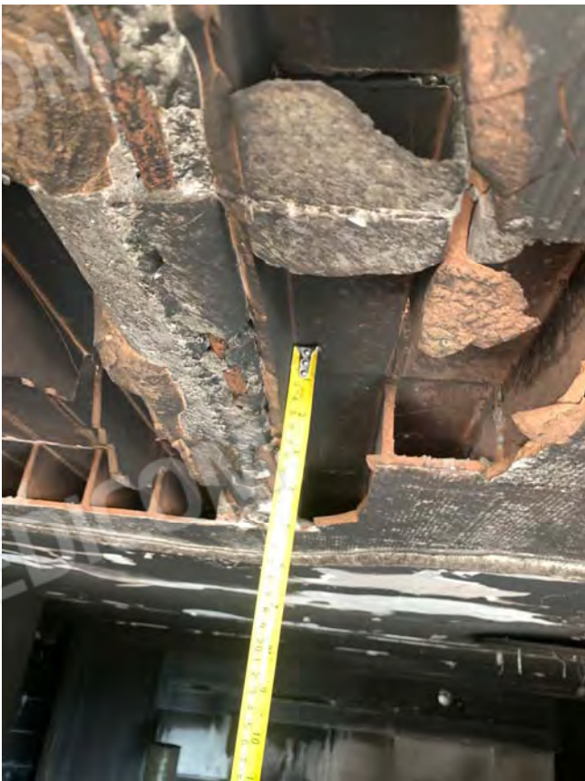
Dettagli del solaio. Degrado strutturale da esposizione ad alte temperature: pignatte esplose
