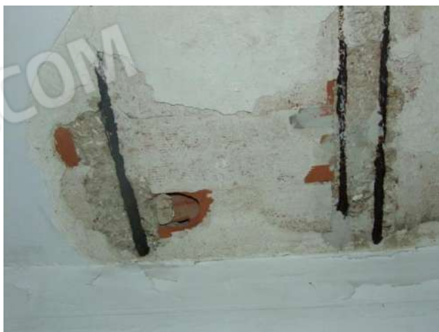
Foto 32 e 33 - Vano 3 - Zone ammalorate con evidenza di ferri di armatura scoperti e arrugginiti
