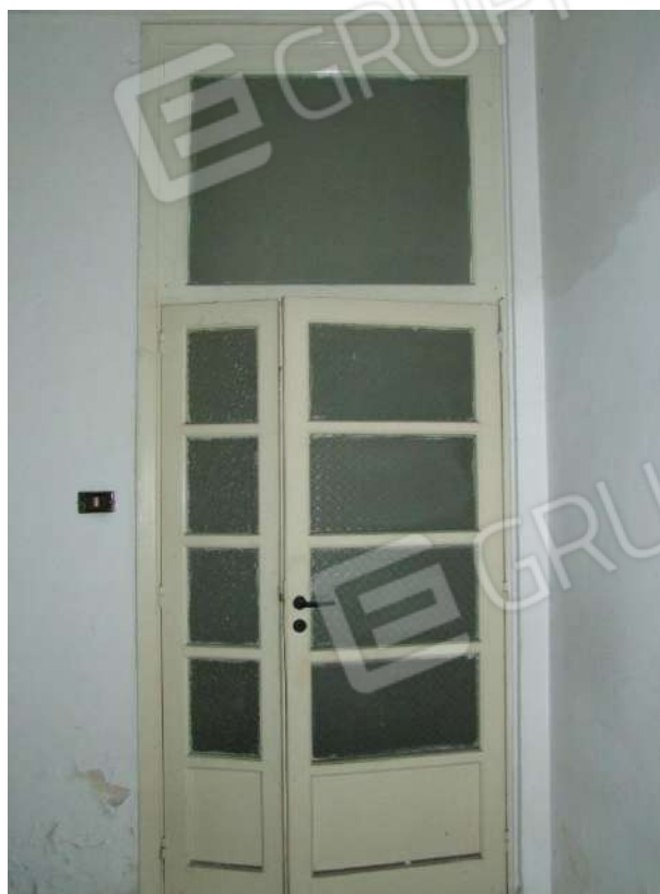
Foto 30 - Particolare infisso interno
