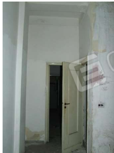
Foto 12 - Vista verso la porta del Vano 2
