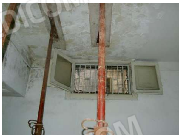
Foto 29 - Particolare infisso esterno
