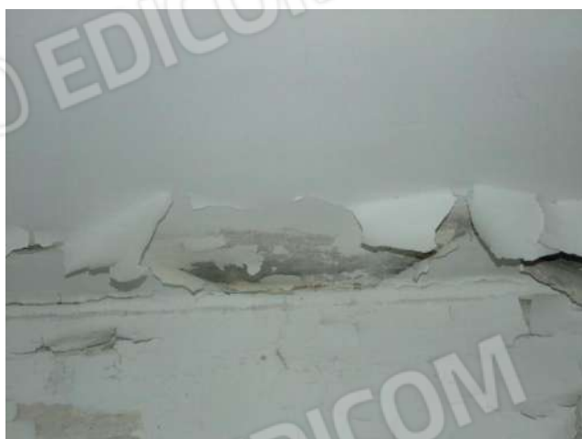
Foto 34 e 35 - Vano 3 e disimpegno - Condizione di degrado degli intonaci
