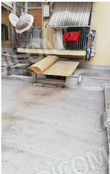
Foto 24 - Vista verso il solaio di copertura del disimpegno
