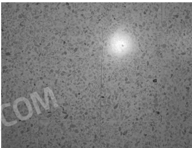
Foto 45 - Particolare pavimentazione esterna delle Logge
