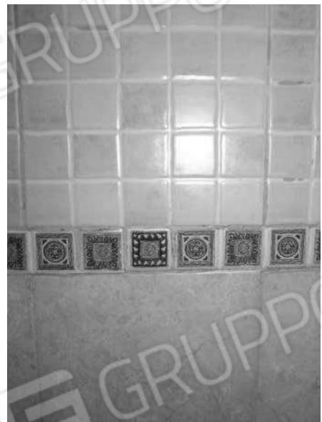
Foto 51 – Particolare rivestimento del bagno WC 1.
