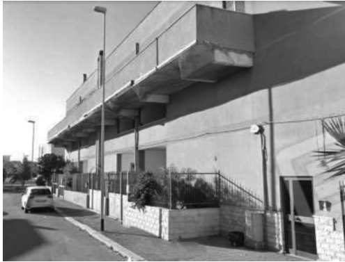
Foto 1 – Vista dell'edificio su via C. Cattaneo.
