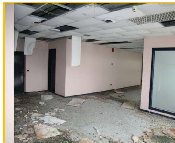
Particolare della controsoffittatura
