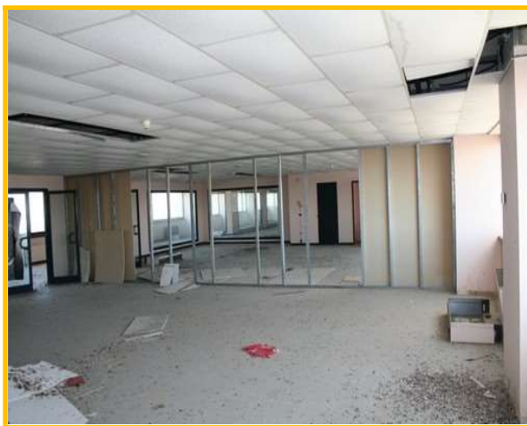
Particolare della tramezzatura
