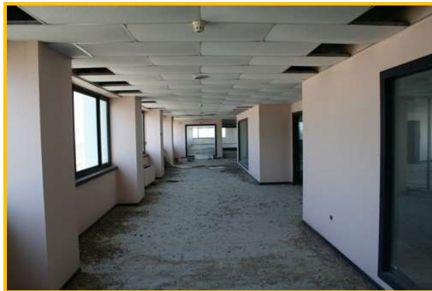
Locale piano tipo Torre B, in cui è visibile la presenza del controsoffitto
