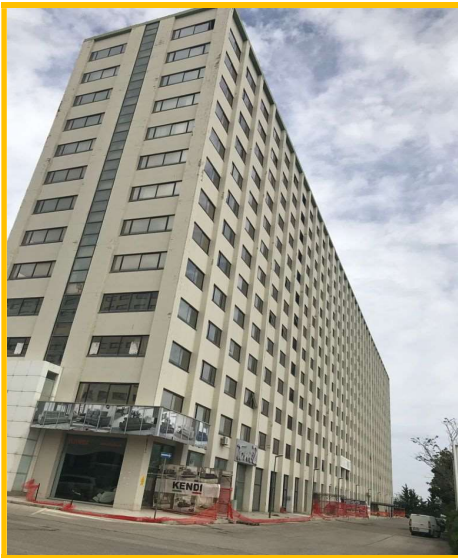
Vista dell'edificio "Torre B"
