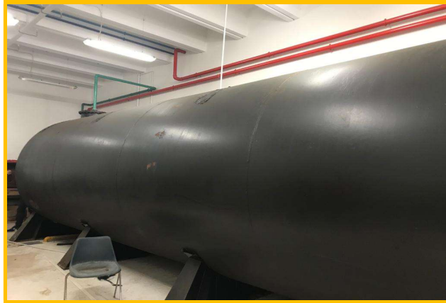
Locale vano tecnico al piano terra della scala A Torre B, in cui è visibile la struttura degli orizzontamenti
