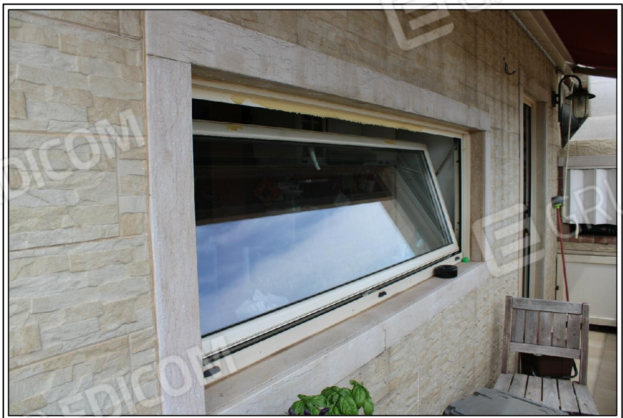
FOTO N° 32 - PARTICOLARE INFISSI ESTERNI
