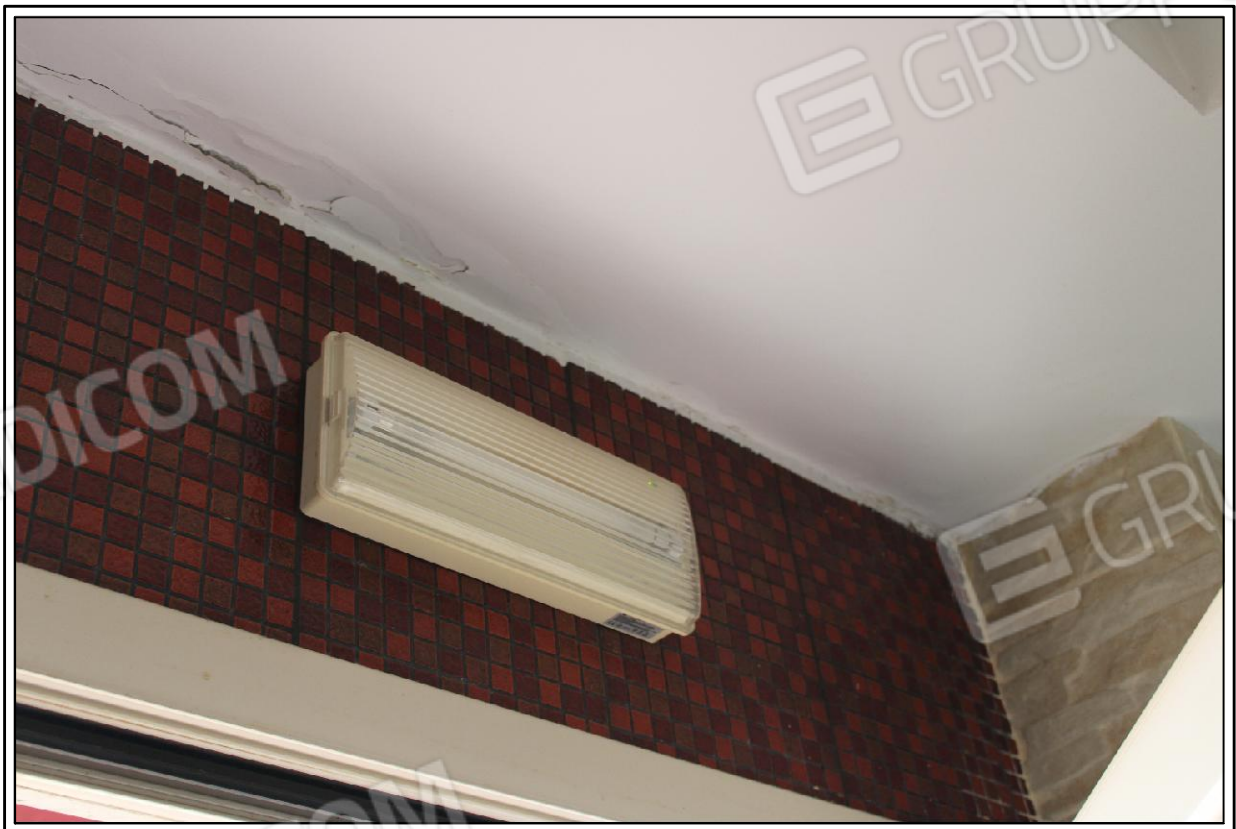
FOTO N° 36 - PARTICOLARE IMPIANTO LUCI D'EMERGENZA
