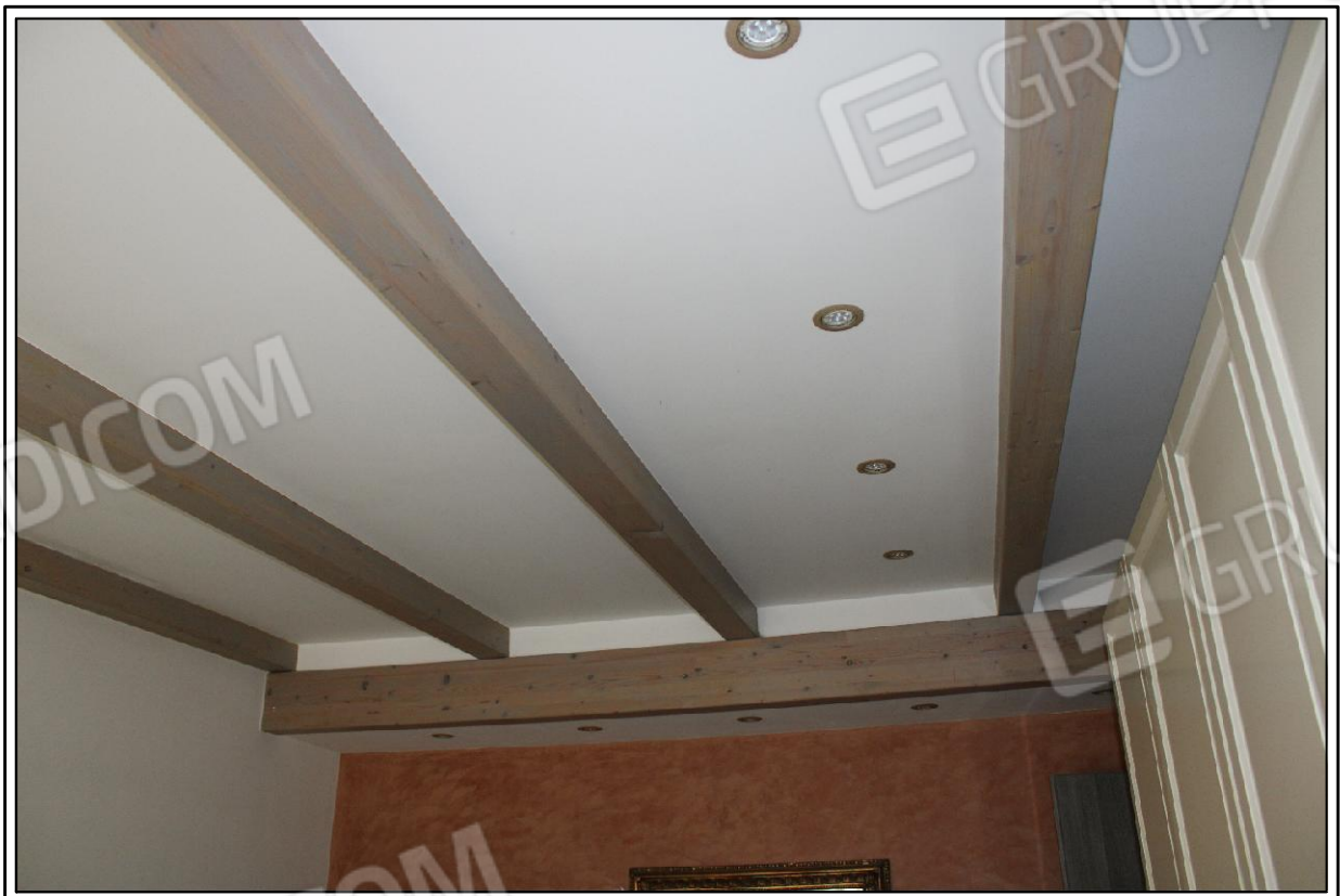
FOTO N° 42 - PARTICOLARE COPERTURA CAMERA DA LETTO 2
