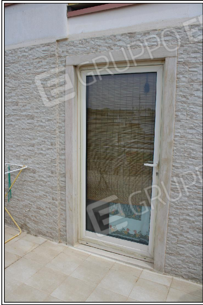
FOTO N° 31 - PARTICOLARE INFISSI ESTERNI
