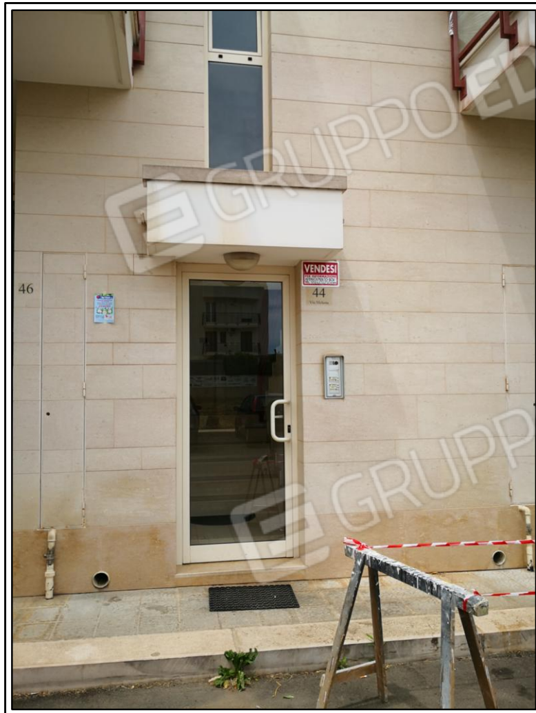
FOTO N° 3 - PORTONE INGRESSO VANO SCALA FABBRICATO
