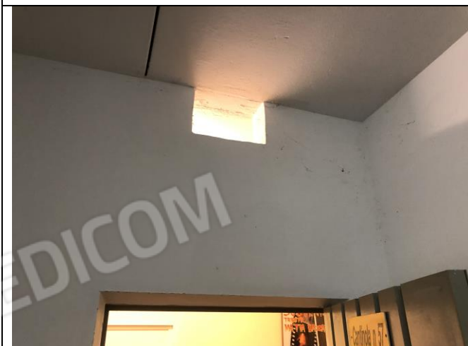
Interno della cantina
