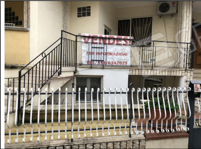
Prospetto del fabbricato
