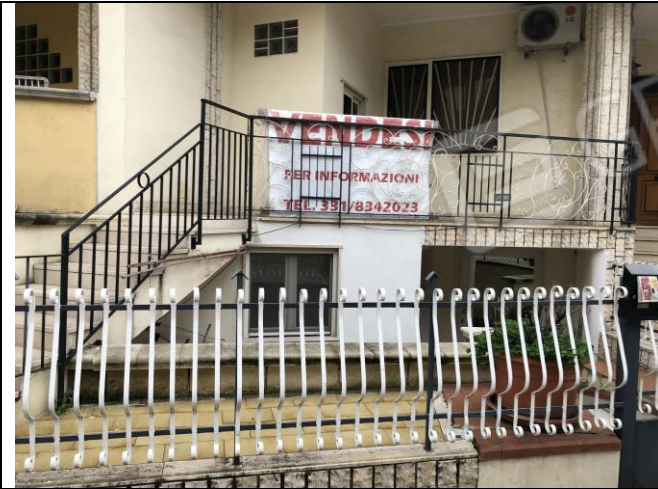
Prospetto del fabbricato
