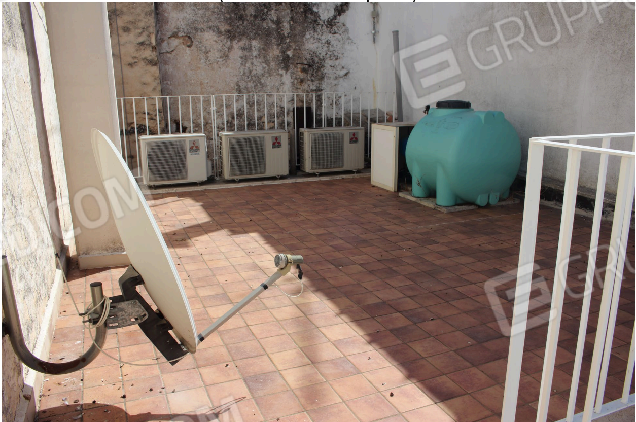
Foto 19 (Vista del lastrico di copertura)
