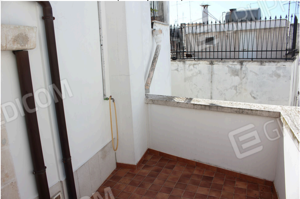
Foto 17 (Vista del piano terzo)
