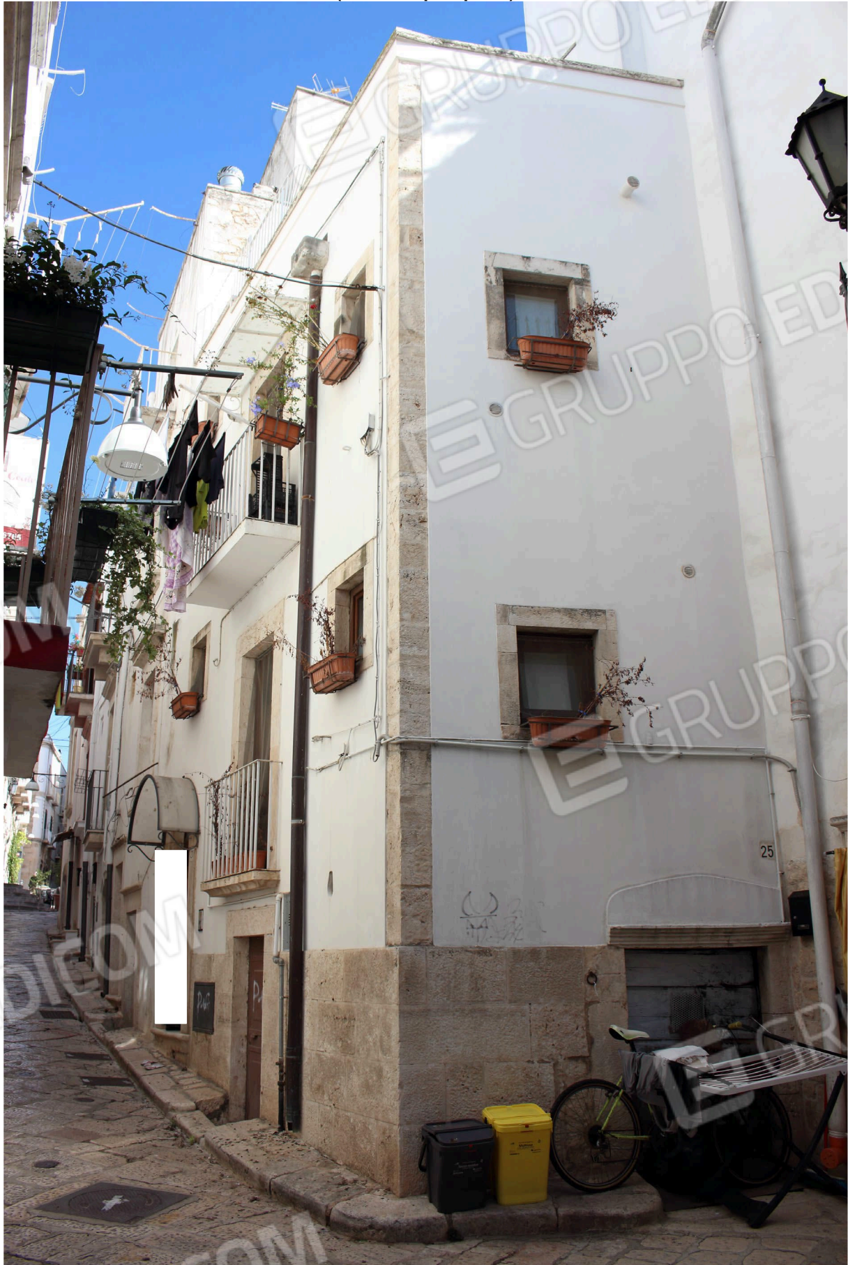
Foto 1 (Vista del prospetto)
